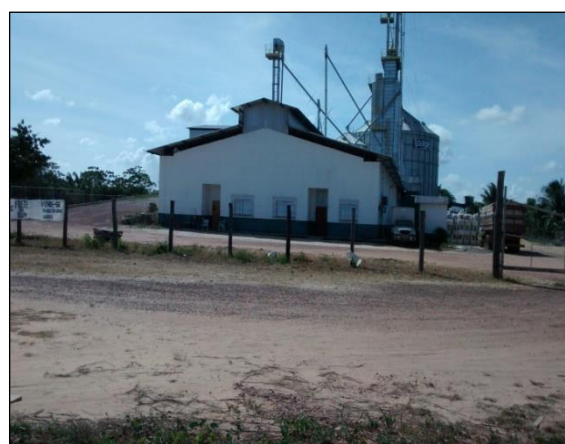
FIGURA 31 – Silo em Salvaterra
