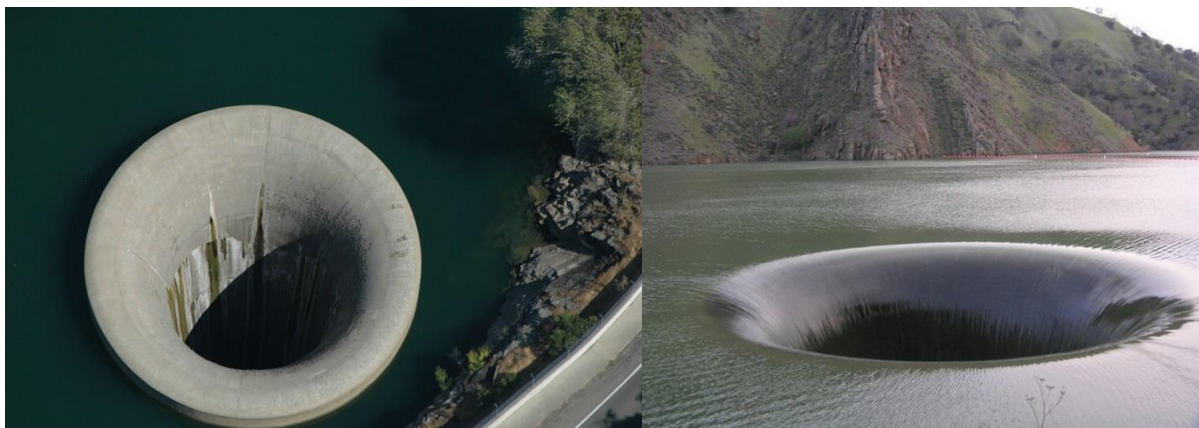
Figura 40 e 41 - Poço de drenagem de água 38
