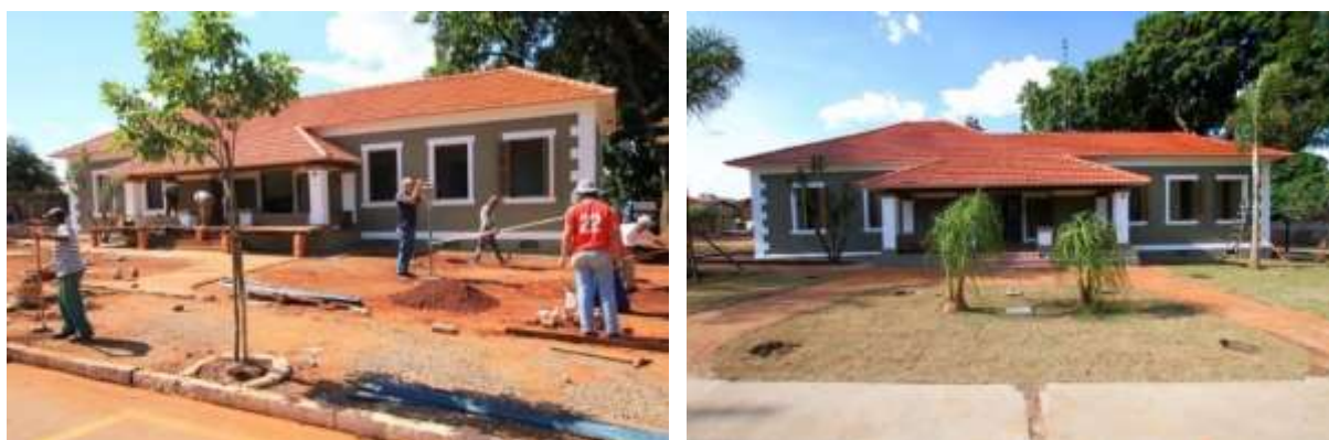
Imagens 114 e 115 - Casa da antiga Companhia Estrada de Ferro São Paulo-Paraná. Membros da Secretaria Municipal de Obras concentrados na fase final de restauração do imóvel. Ano: 2013.
