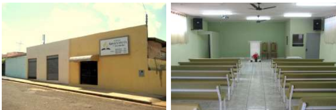
Imagens 86 e 87 - Exterior e Interior do salão alugado pela IASD na Vila Boa Esperança. Aspectos do prédio após a reforma geral. Ano: 2012. Fonte: Acervo de André Pires do Prado.
