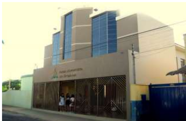
Imagem 73 - Fachada do templo da Vila Musa após a pintura geral realizada em 2011. Ano: 2012. Fonte: Acervo de André Pires do Prado.
