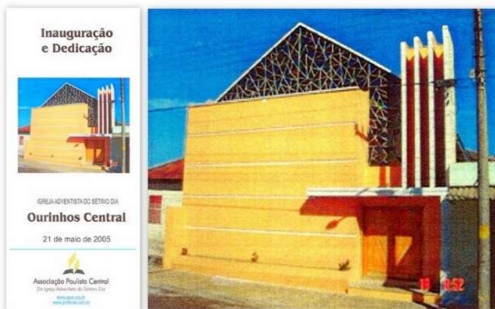
Imagem 61 - Perspectiva frontal do templo da IASD na Vila Perino após o processo de demolição e reconstrução de sua estrutura em mutirão. Local: Vila Perino. Ano: 2005. Fonte: Arquivo de Nilce Ruy Christoni.
