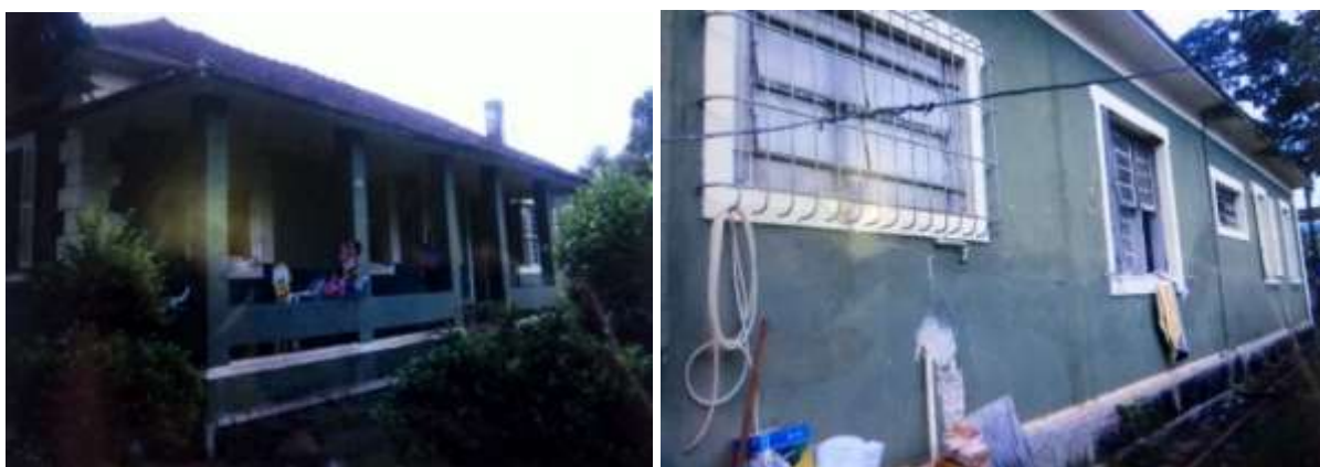
Imagens 47 e 48 - Casa situada na Av. Rodrigues Alves, nº 100, na esquina com a Rua Engenheiro Frontin, no mesmo quarteirão da casa nº 170. Fonte: Processo de Tombamento nº 17.813/2008.
