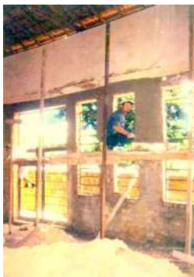
Imagem 132 - Templo da IASD-Vila Brasil durante a construção da nave de cultos. João de Moura Sobrinho aplicando o reboco nas paredes. Ano: entre 1996 e 1997. Fonte: Neuza R. de Moura.
