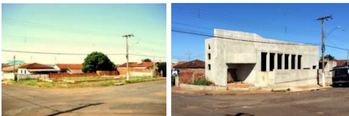
Imagens 82 e 83 - À esquerda, perspectiva do terreno adquirido pela IASD na Vila São Luiz em 2008 e o alicerce de sustentação do templo. À direita, perspectiva do templo edificado em mutirão pela comunidade. Ano: 2011 e 2016. Fonte: Acervo de André Pires do Prado.
