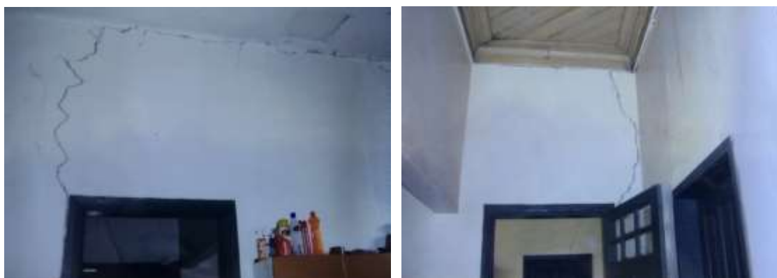
Imagens 122 e 123 - Interior da casa nº 100 da Avenida Rodrigues Alves. Rachaduras afetando a estrutura da casa e colocando em risco a própria vida do morador. Fonte: Processo nº 17.813-1/2008.
