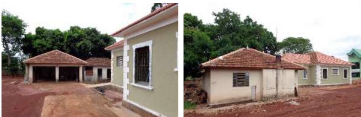
Imagens 107 e 108 - Perspectiva lateral do imóvel nº 170 da Av. Rodrigues Alves. Ano: 2013. Fonte: André Pires do Prado.
