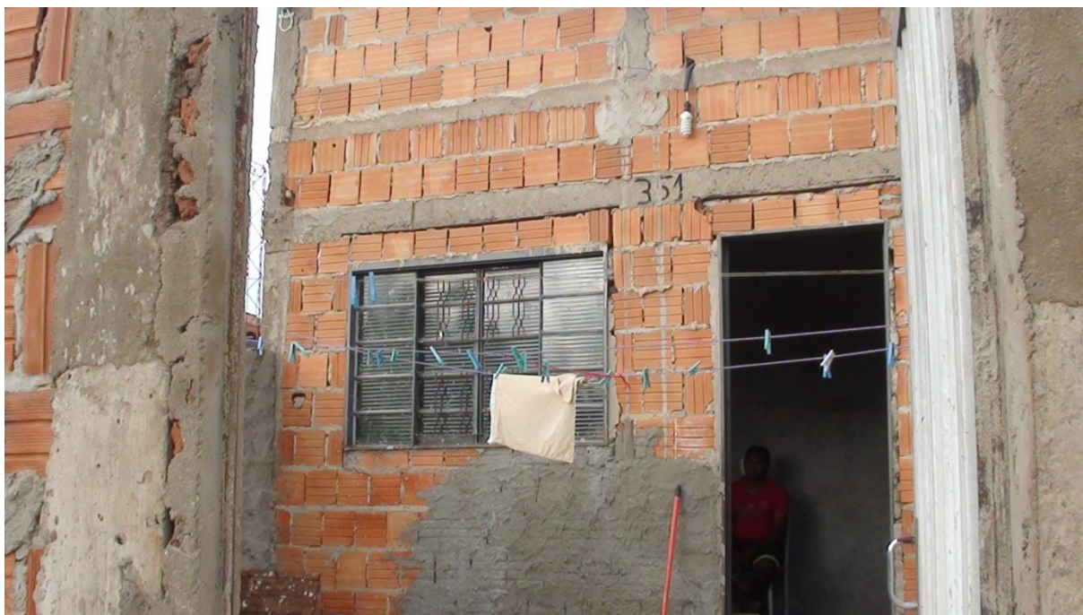
Foto 29: Vista externa da casa de Wagno e Luziane, construída no Nova Santa Lúcia. Fonte: Pesquisa de campo, 2015.
