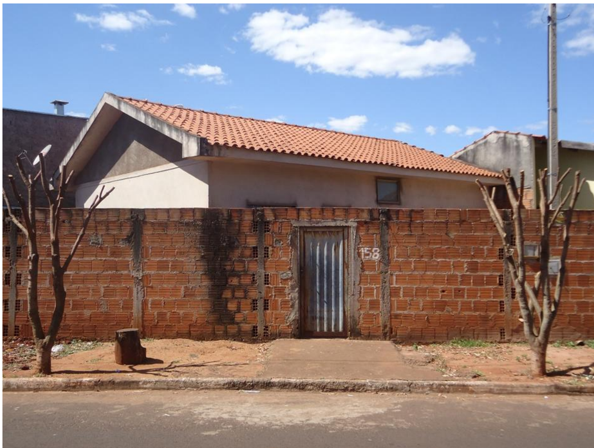
Foto 33: Vista externa da casa de Francisco, construída no Nova Santa Lúcia. Fonte: Pesquisa de campo, 2015.
