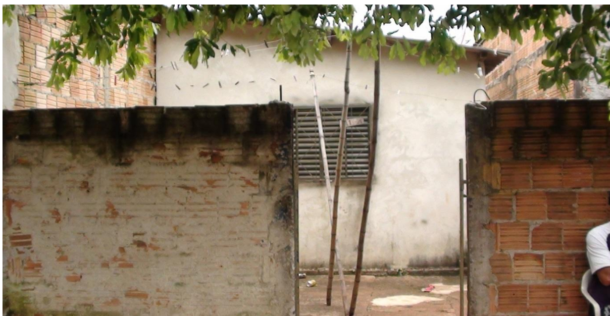
Foto 27: Vista externa da casa de Henrique, construída no Nova Santa Lúcia. Fonte: Pesquisa de campo, 2015.
