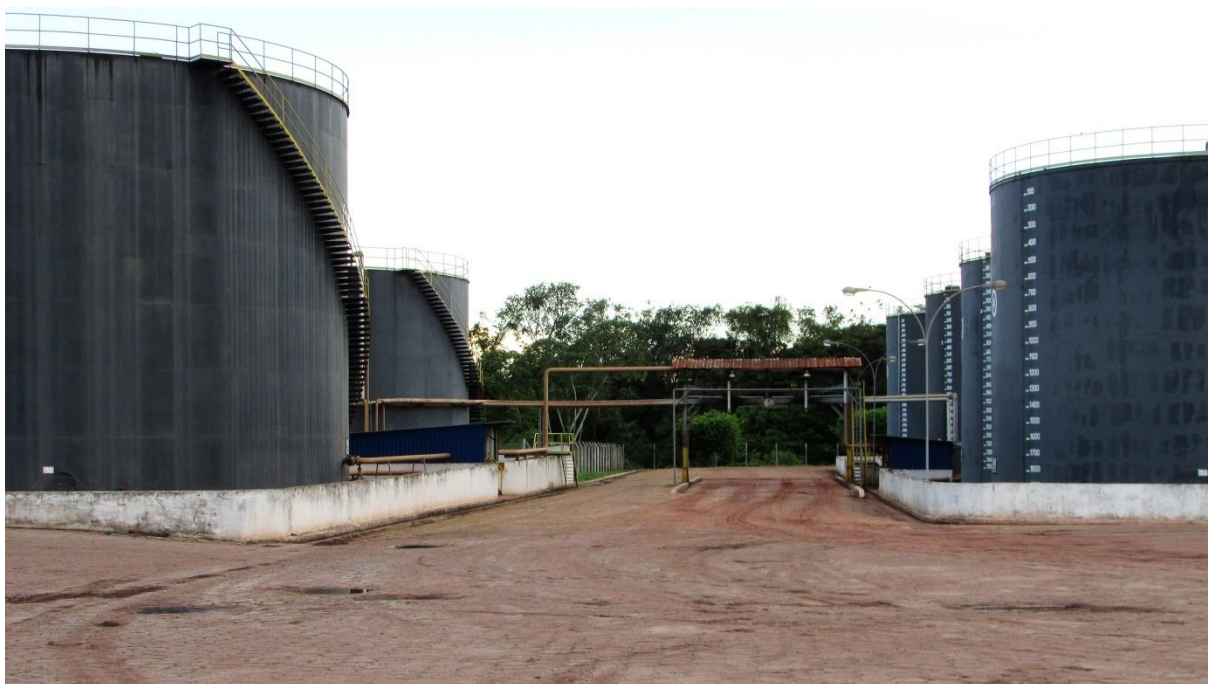
Figura 60: Tanques da Companhia Real Agroindustrial (CRAI).
