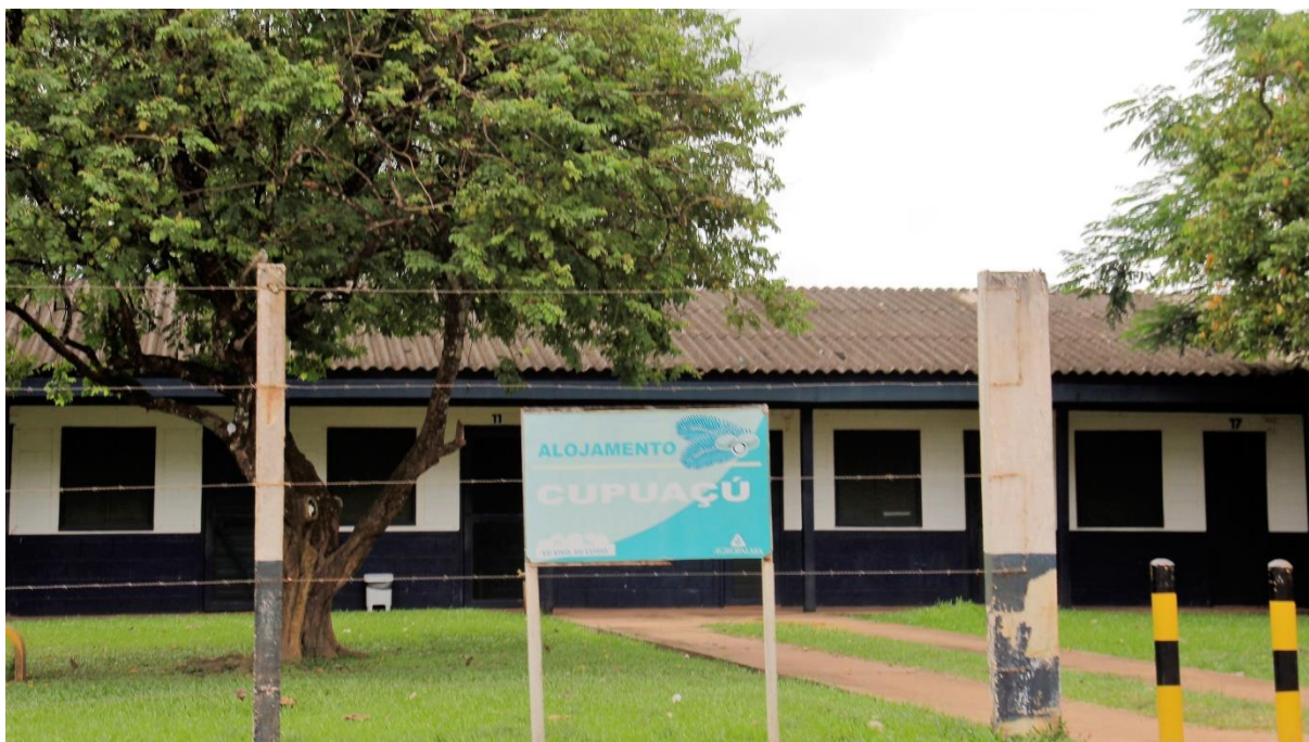
Figura 67: Alojamento "Cupuaçu" para trabalhadores da Agropalma.
