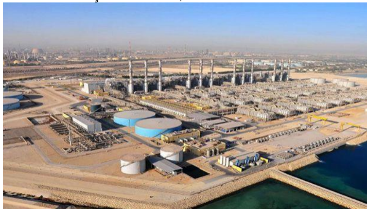
Figura 12 - Usina de dessalinização em Jubail, Arábia Saudita.
