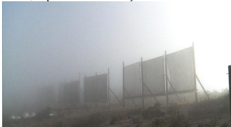
Figura 10 - Atrapaniebla , dispositivo de condensação de nuvens no Chile.
