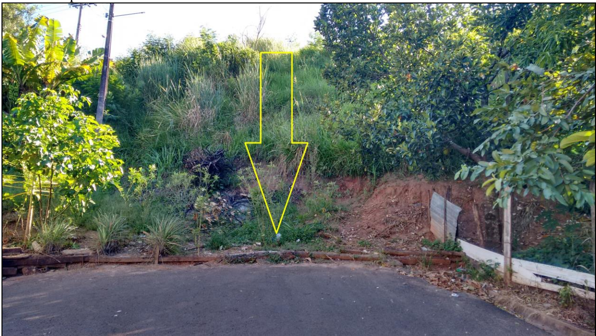
Figura 97: Área de ruptura de declive, com aproximadamente 3,5 metros de comprimento, entre a Rodovia Raposo Tavares e a Vila Nova Prudente
