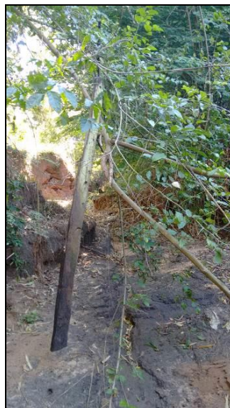
Figura 90: Imagem da cerca delimitadora da propriedade rural. Nota-se que ela encontra-se suspensa na área da feição erosiva
