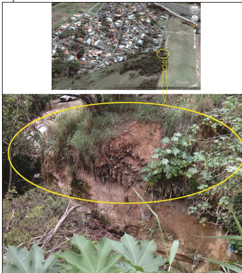
Figura 70: Localização e imagem da antiga área de deposição de resíduos sólidos domésticos entre o Recinto de Exposições e a Vila Nova Prudente
