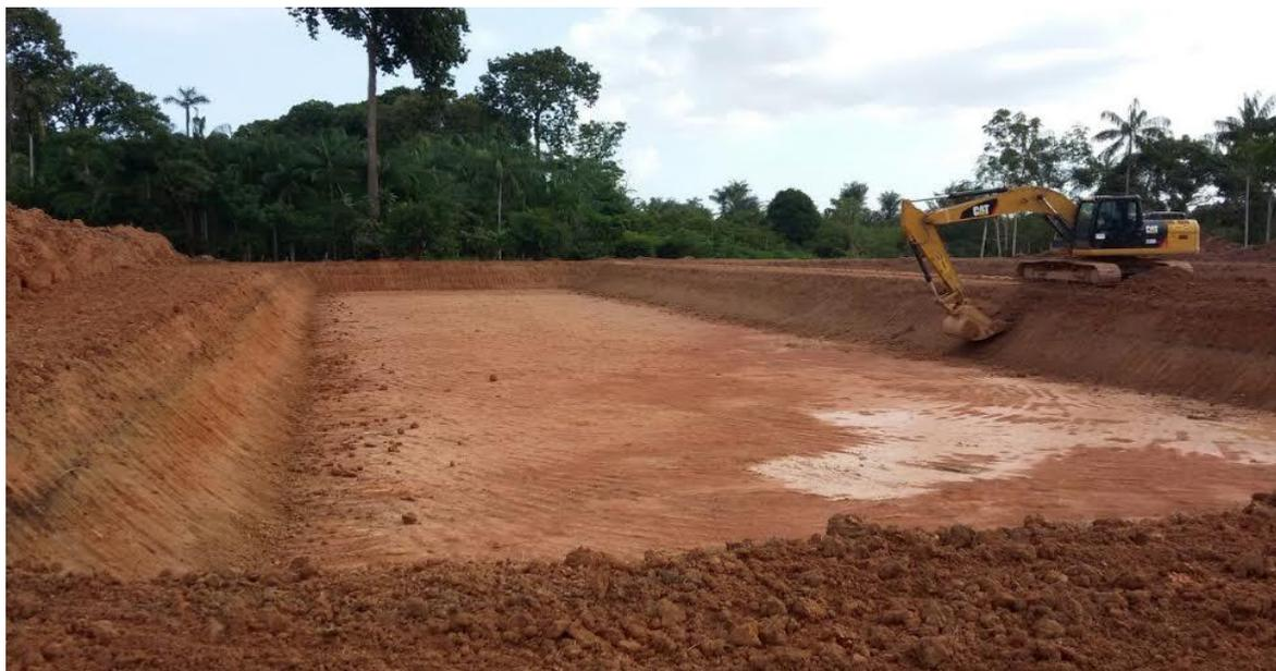
**Figura 7.** Construção de tanque escavado destinado à piscicultura semi-intensiva.
