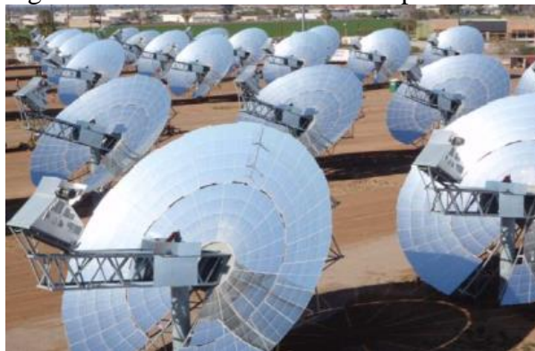
Figura 23 – Planta solar de Maricopa com tecnologia Stirling.
