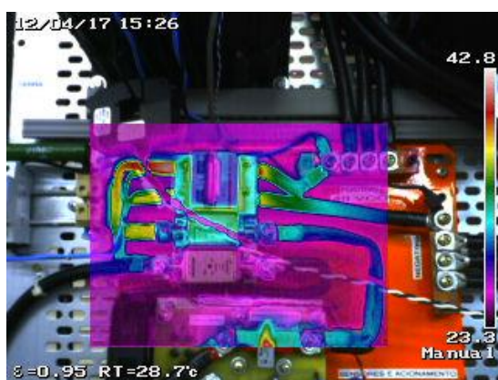
Disjuntor de conexão CC
