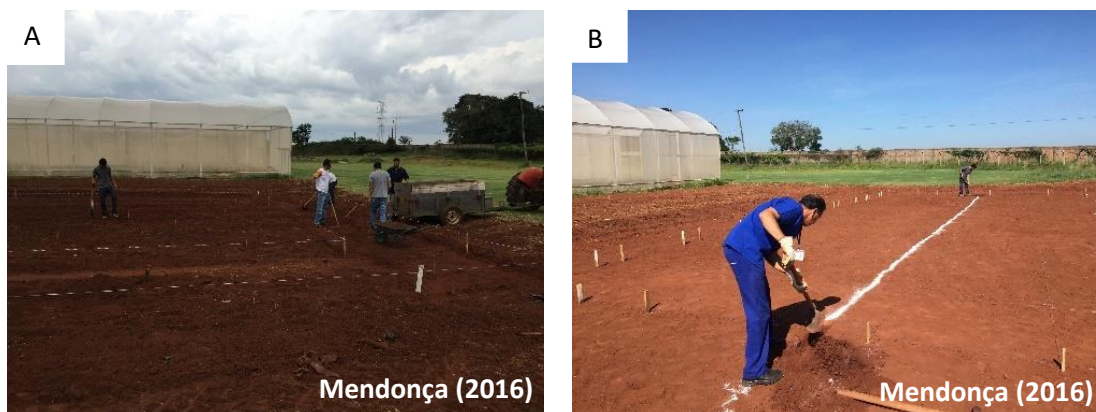
Figura 2 - Delimitação da área (A), marcação e abertura das valetas (B)
