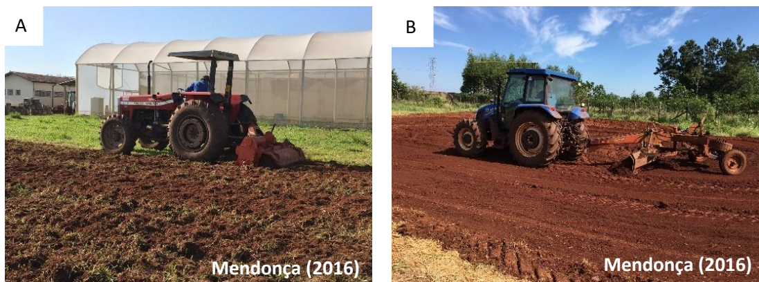
Figura 1 - Enxada rotativa (A), nivelamento do terreno (B)
