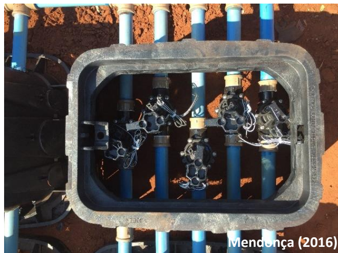
Figura 5 - Instalação de cinco das dez válvulas solenoides
