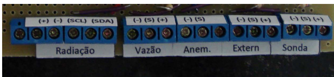
Figura 31: Terminais para conexão dos sensores.
