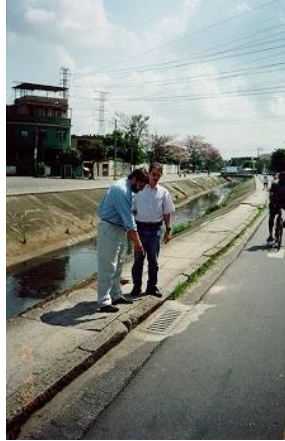
Figura 8 - Exemplo de posicionamento correto de grelha em ciclofaixa. Fonte: GEIPOT (2001a)
