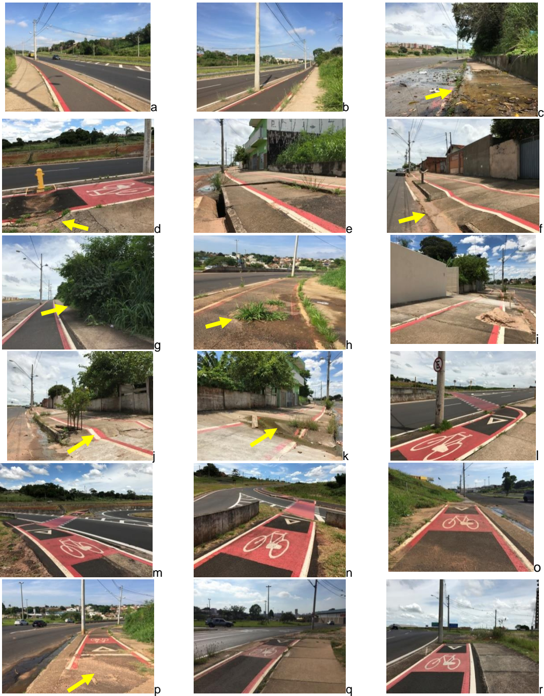
Figura 95 - Levantamento de campo – Ciclovia Nações Unidas Norte
