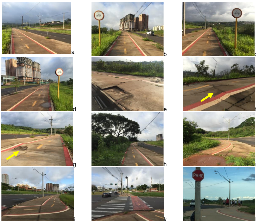
Figura 98 - Levantamento de campo – Ciclovía na Avenida da Água Comprida
