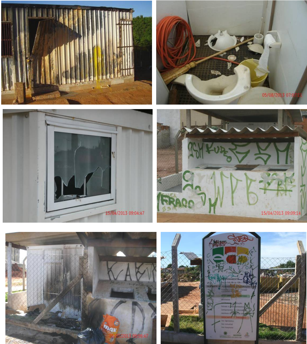
Figura 4.42 - Resultados de ações de vandalismo em ecopontos de Bauri (Fonte: acervo da SEMMA-Bauri)
