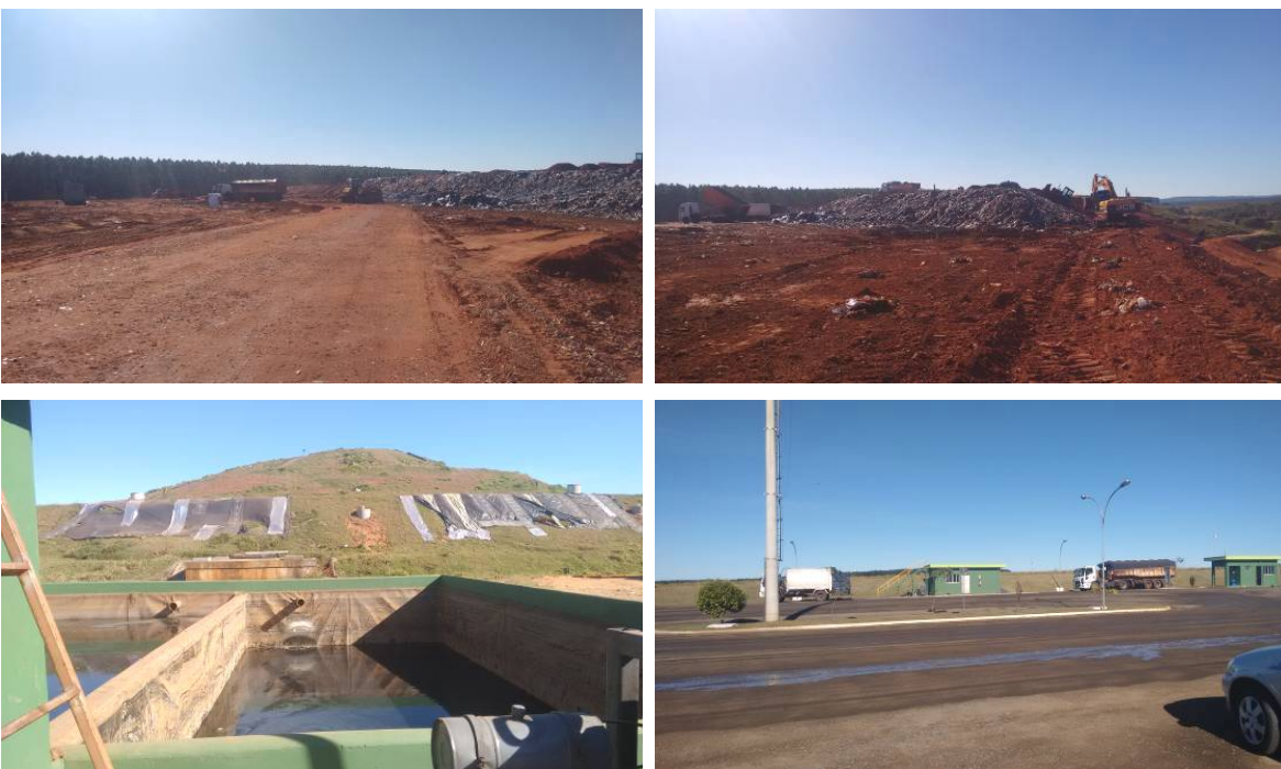
Figura 2.03 - Aspectos do aterro sanitário em Bauru-SP
