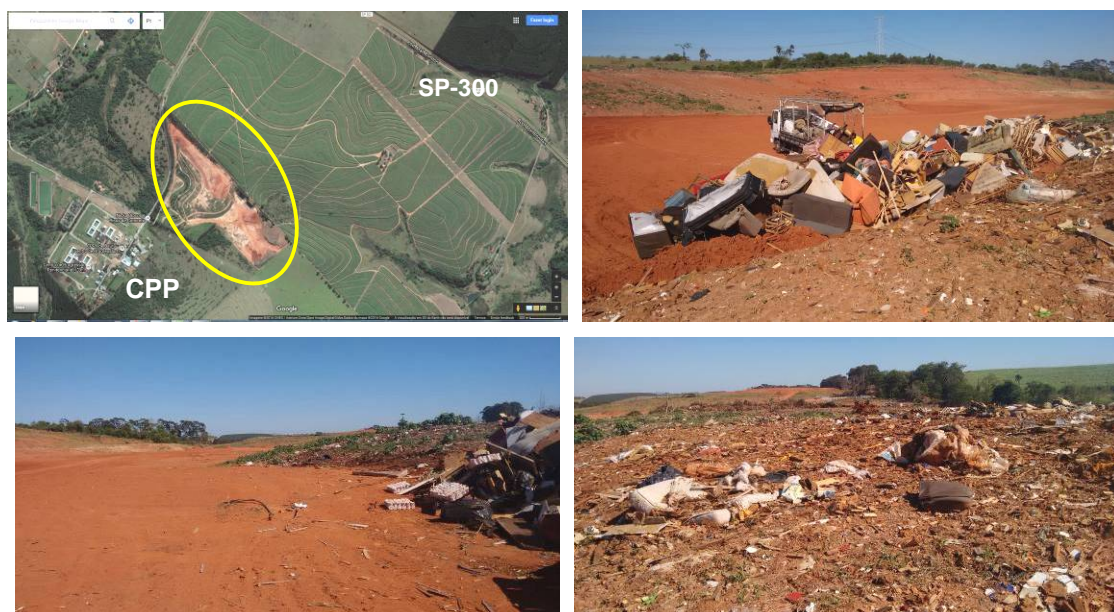
Figura 4.50 - Localização do aterro sanitário de Bauru-SP, próximo aos CPP (Centros de Progressão Penitenciária I e II), e aspectos gerais de suas instalações (Fontes: Imagem aérea, Google; fotos da autora)
