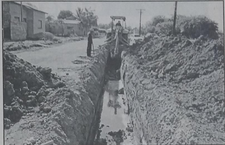
Além dos serviços de drenagem, a Tancredo Neves será recapeada
