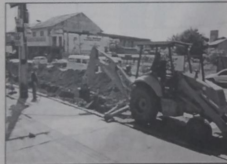
A empresa responsável pelas obras iniciou os trabalhos de escavação
