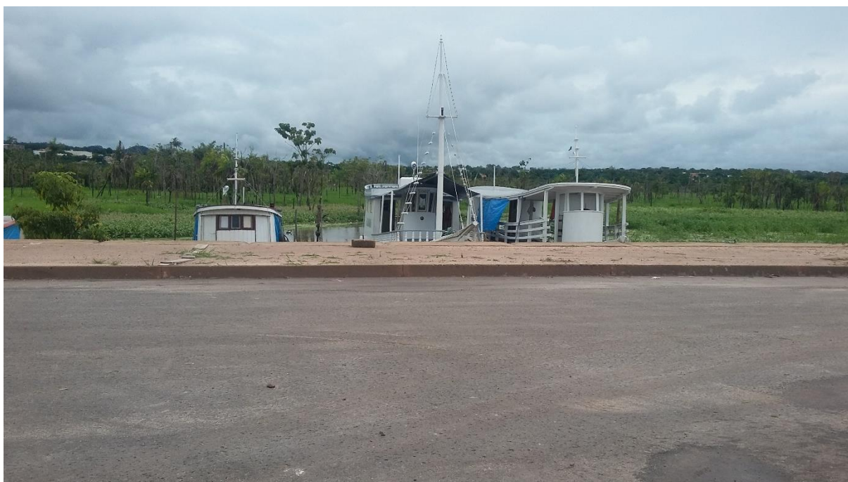
Figura 25 – Parte da Orla do Mapiri que recebeu aterro e pavimentação para conter a inundação fluvial. Fonte: Trabalho de campo. Data da foto: 15 de março de 2017. Autoria da foto: Maria Júlia Veiga da Silva.
