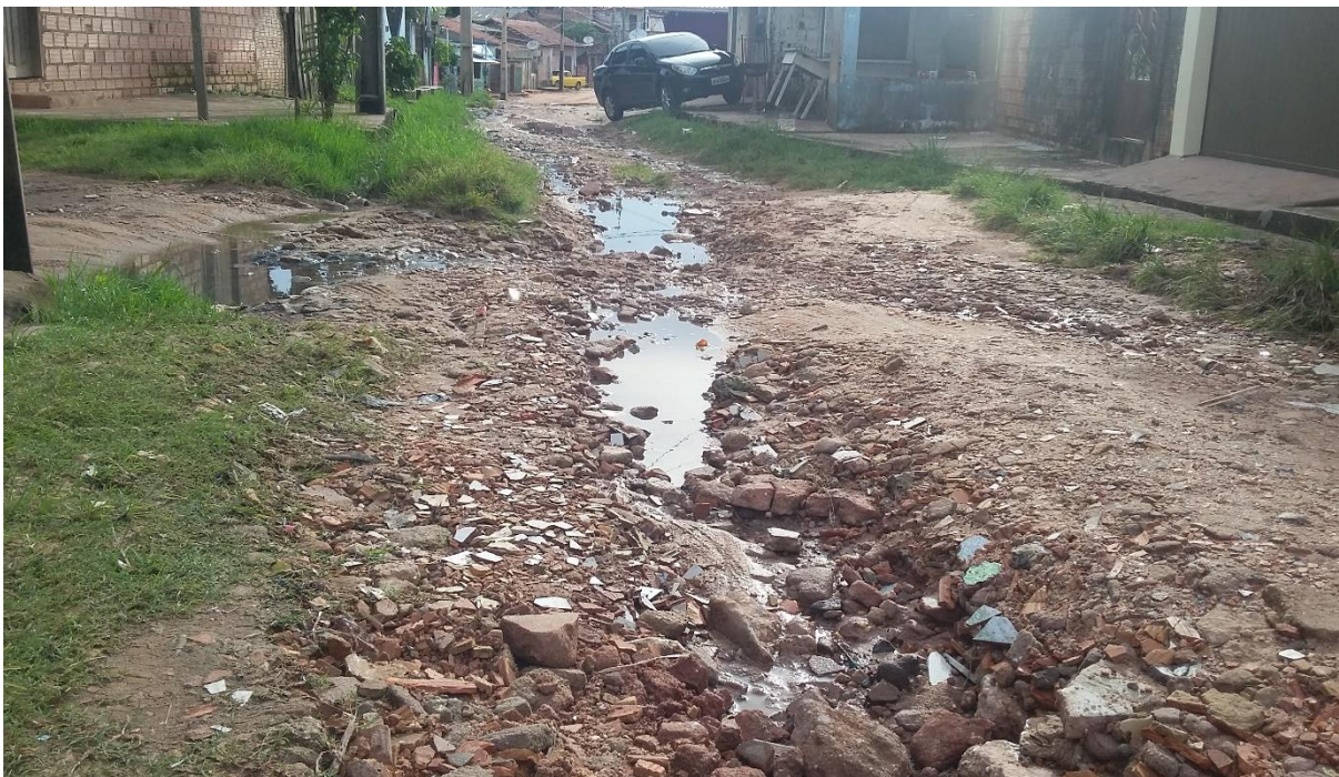
Figura 33 – Estado de conservação da rua Sofia Imbiriba no bairro Mapiri. Fonte: Trabalho de campo. Data da foto: 14 de março de 2017. Autoria da foto: Maria Júlia Veiga da Silva.
