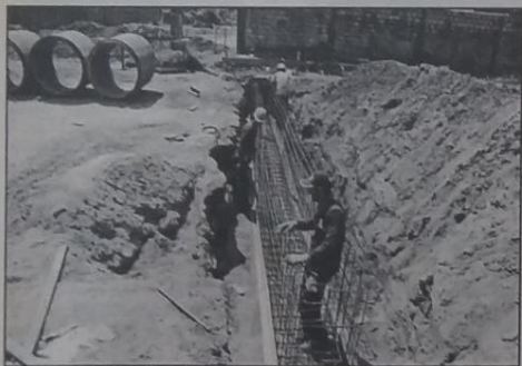
O serviço de drenagem profunda na rua Margarida
