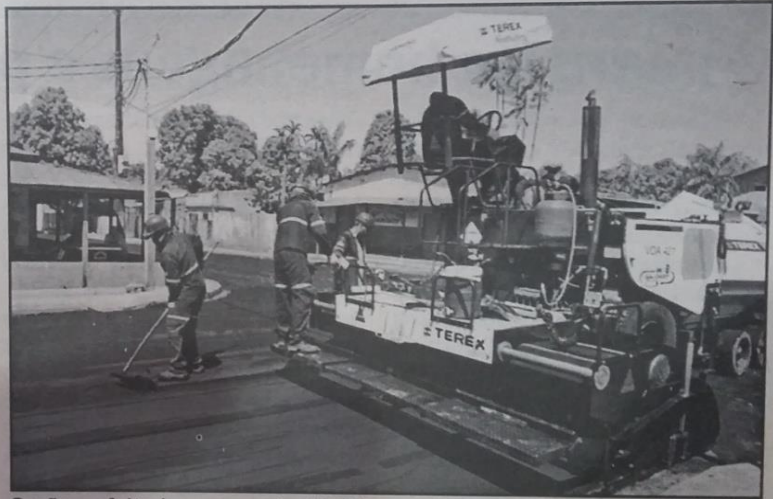
Serão asfaltados cerca de 1.965 metros de extensão da avenida
