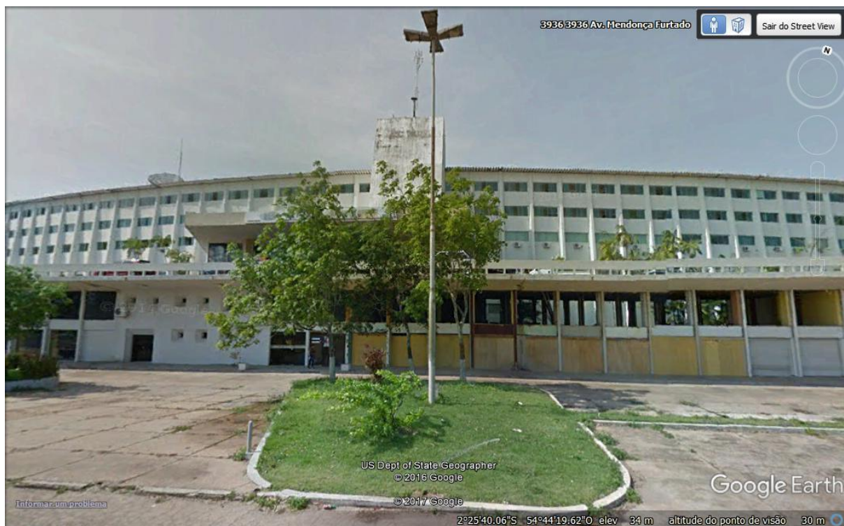
Figura 17 – Fachada do Hotel Tropical na Avenida Mendonça Furtado no Bairro Liberdade na cidade de Santarém-PA. Fonte: Google Earth. Extraído em 04 de junho de 2017.
