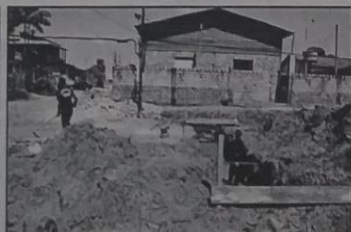
Na Magnólia a drenagem foi iniciada
