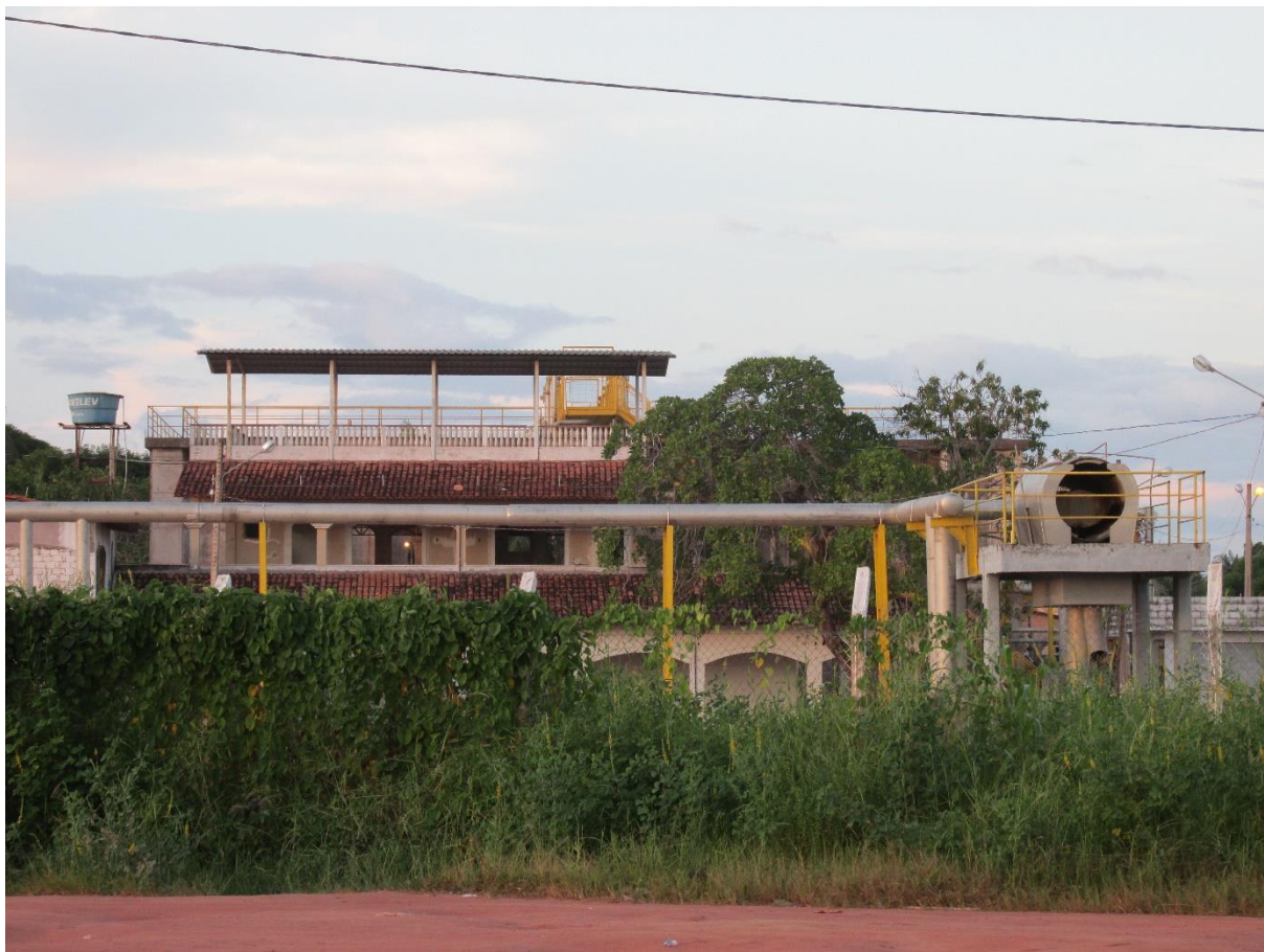
Figura 28 – Estação de tratamento de esgoto próximo ao lago Mapiri no bairro Mapiri. Fonte: Trabalho de campo. Data da foto: 19 de maio de 2016. Autora Maria Júlia Veiga da Silva
