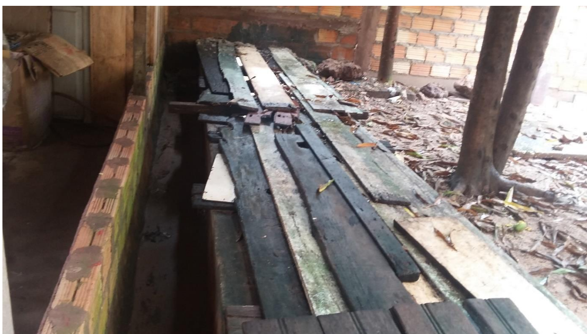
Figura 24 – Canaleta no quintal de uma moradia do bairro Mapiri. Fonte: Trabalho de campo. Data da imagem: 14 de março de 2017.
