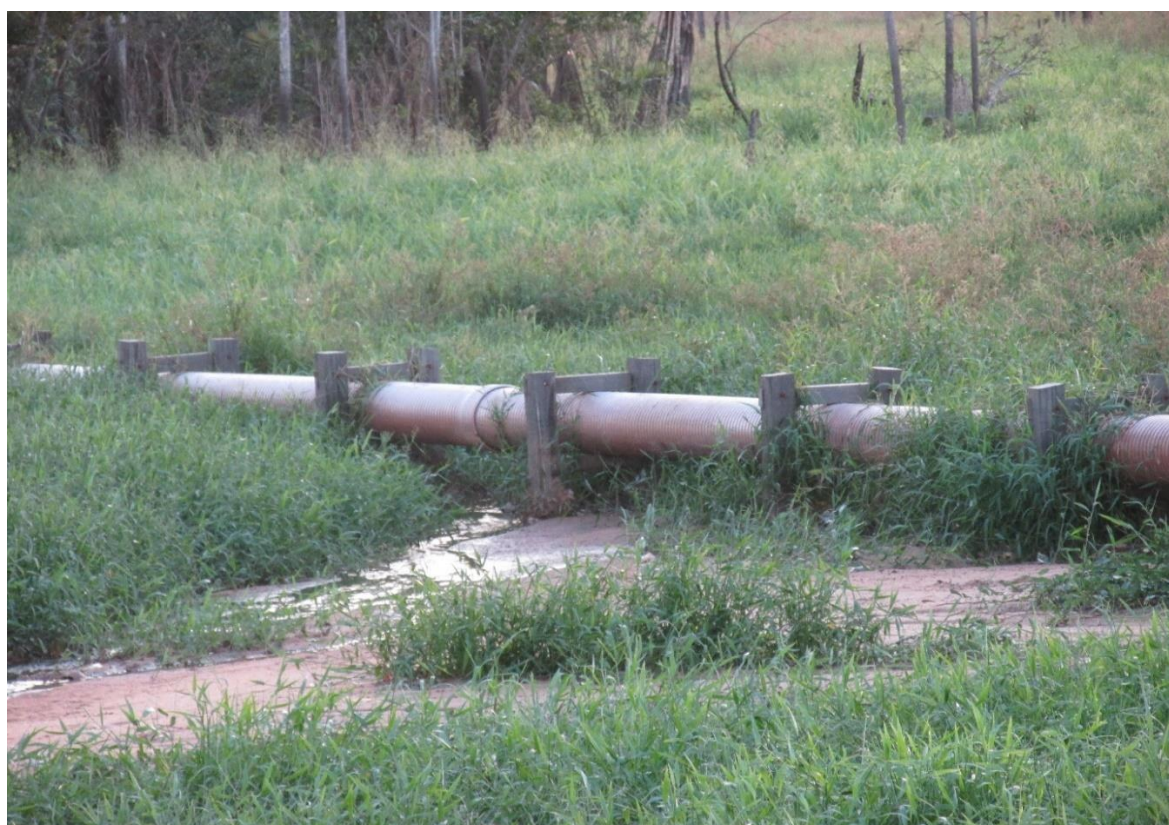
Figura 31 – Tubo da estação do tratamento de esgoto sobre o lago Mapiri. Fonte: Trabalho de campo. Data da foto: 19 de maio de 2016. Autora Maria Júlia Veiga da Silva.
