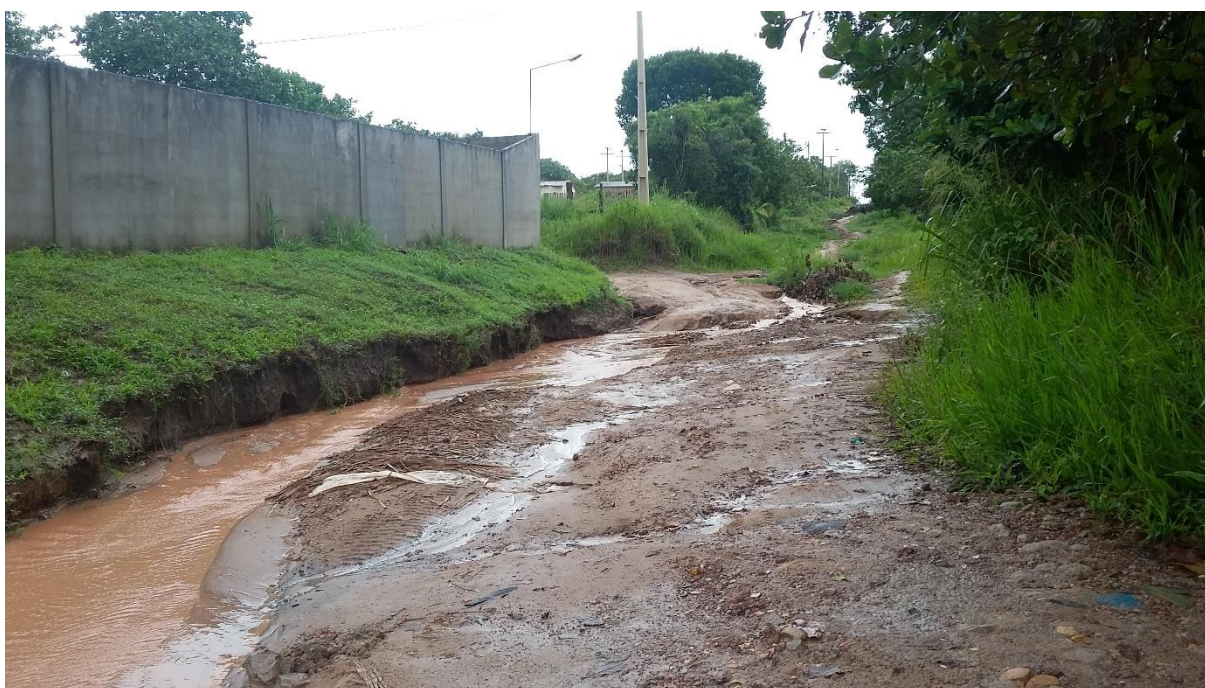
Figura 21 – Situação de uma rua no bairro Pérola do Maicá após a ocorrência de chuva. Fonte: Trabalho de campo. Data da foto: 16 de março de 2017. Autoria da foto: Maria Júlia Veiga da Silva.
