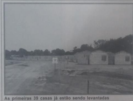
As primeiras 39 casas já estão sendo levantadas
