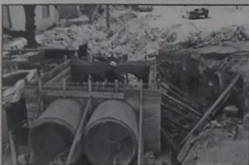
Na avenida Curuá-Una a tubulação foi colocada
