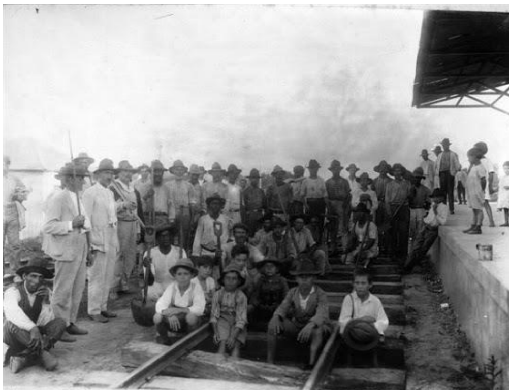
Figura 29 - Trabalhadores da Construção do Ramal Pirajuhy (1925)
