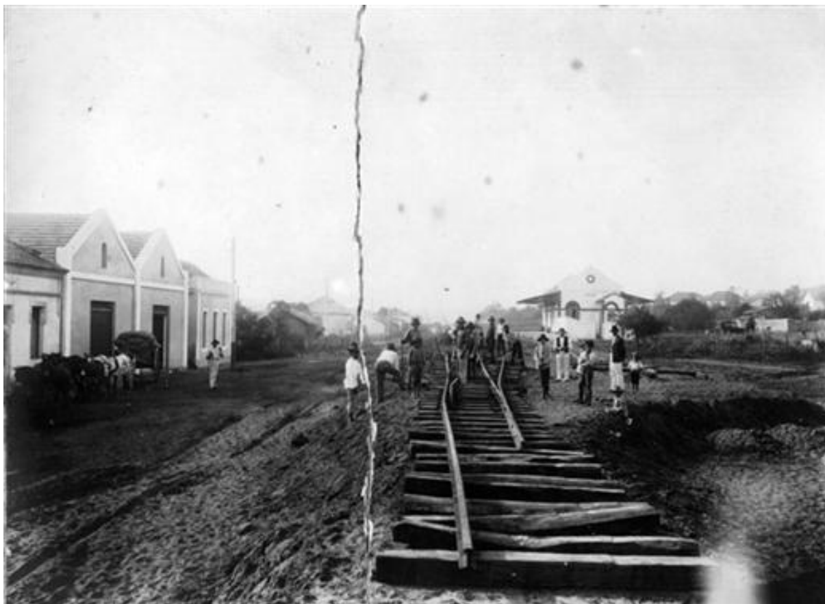
Figura 32 - Finalização das obras do Ramal Pirajuhy (1925)
