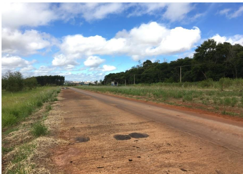
Figura 5 - Pista de concreto.
