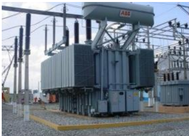
Figura 3. 10- Transformador com comutador sob carga
