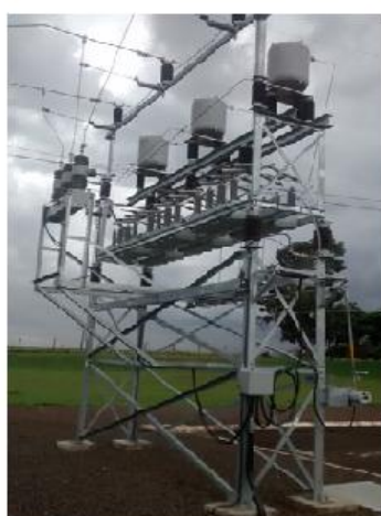
Banco Fusível de Expulsão
