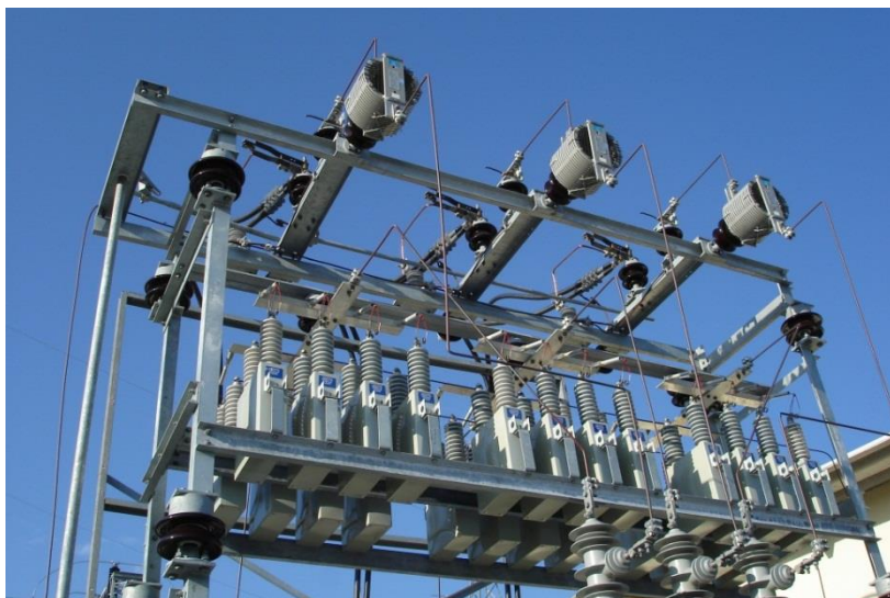
Figura 3.12- Bancos de capacitores de subestação
