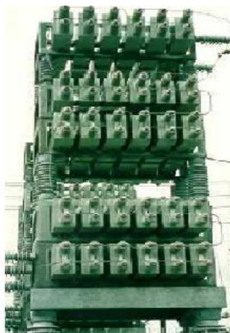
Banco Fusível Interno
