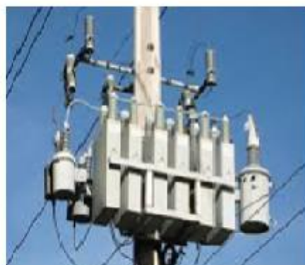
Banco de capacitores automático
