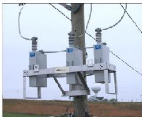
Banco de capacitores fixo
