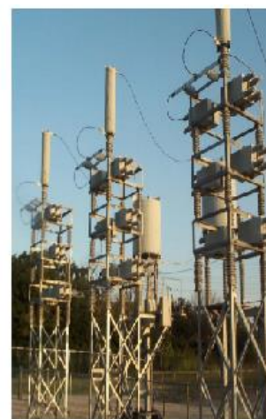
Banco Sem Fusíveis (Fuseless)
