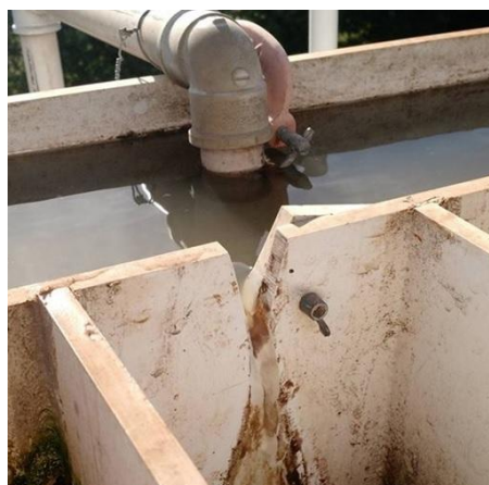
Figura 13 – Vertedouro de controle da vazão de entrada
