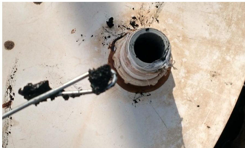
Figura 22 – Obstrução da câmara de gases
