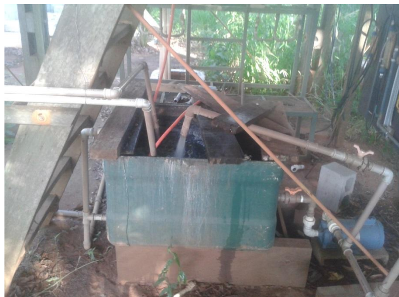
Figura 11 – Reservatório e bomba centrífuga
