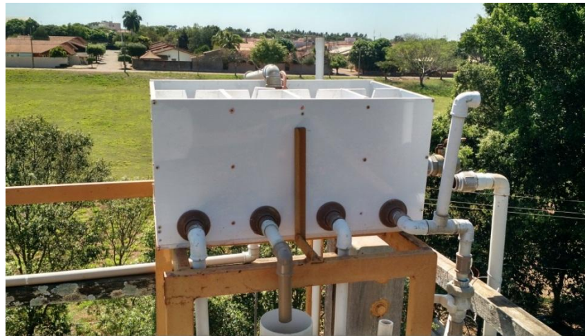
Figura 12 – Caixa de nível
