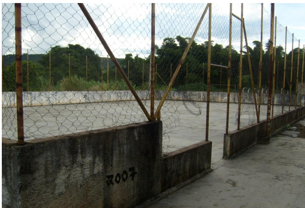
Imagem 32 – Vista da quadra esportiva.
