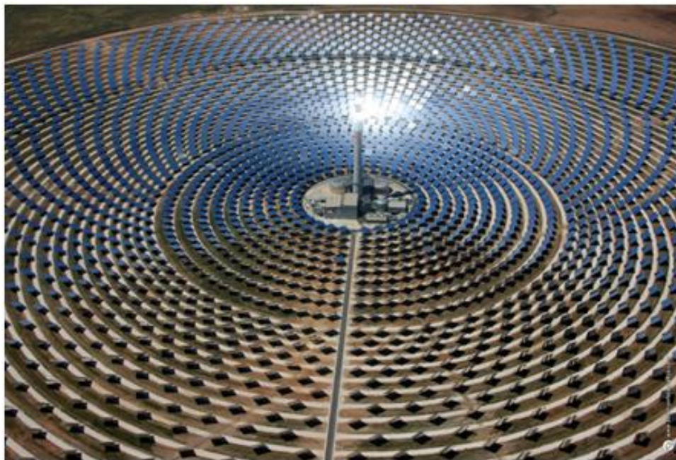
Figura 8 - Usina heliotérmica (CSP) Gemasolar 20MW na Espanha, vista aérea
