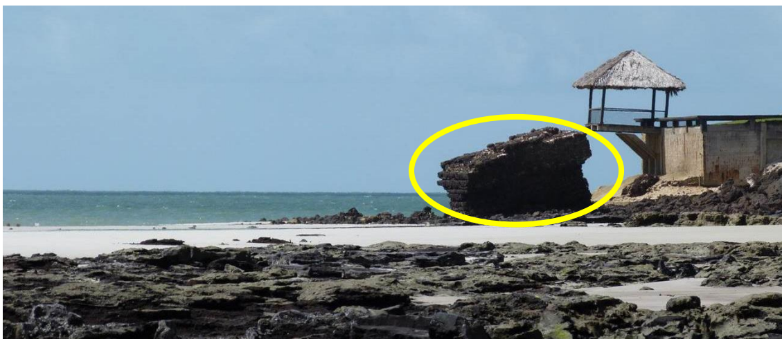
Foto 3: Resquícios da estrutura sobre a qual foi construído os primeiros faróis de Salinópolis.
