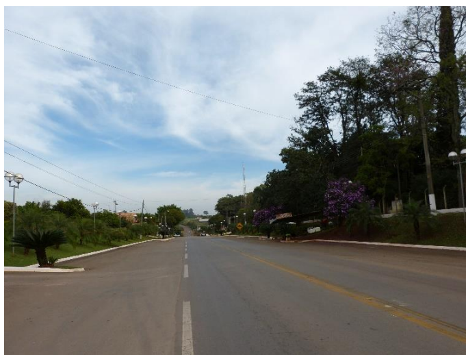
Figura 16 - Rodovia SP- 316 no ano de 2015 – bairro de Cascalho Fonte: Arquivo da autora (2015)
