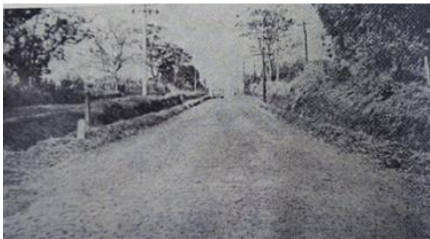
Figura 15 – Início da pavimentação de asfalto na SP-316 – bairro de Cascalho Fonte: Casa da Cultura de Cascalho ([197-]) 90
