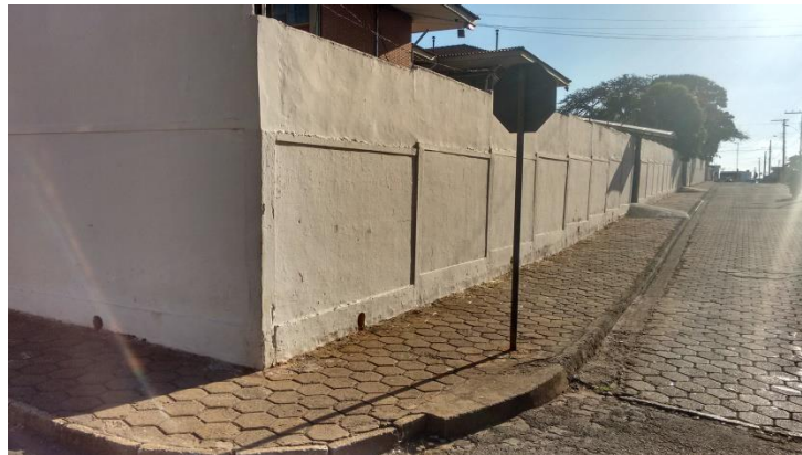
Foto 5 – Escola Estadual São José - Calçada sem rebaixamento
