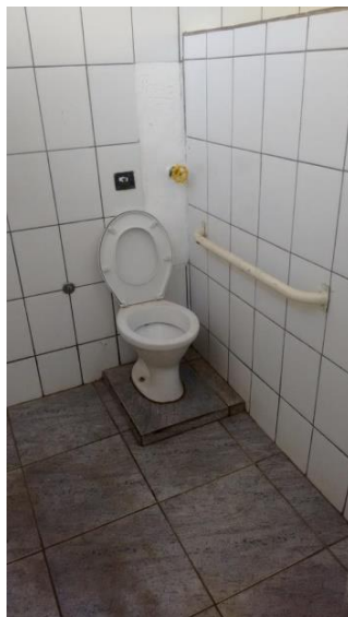
Foto 21– Escola Estadual São José– Box sanitário PCR
