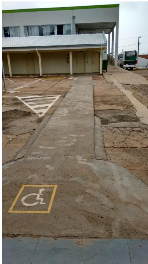
Foto 26 – IFSULDEMINAS – Passarela para passagem pelo estacionamento
