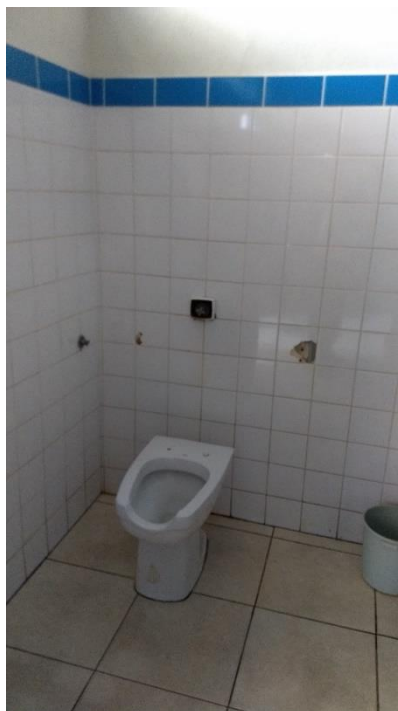
Foto 23 — Escola Municipal Jalile Barbosa- Box sanitário
