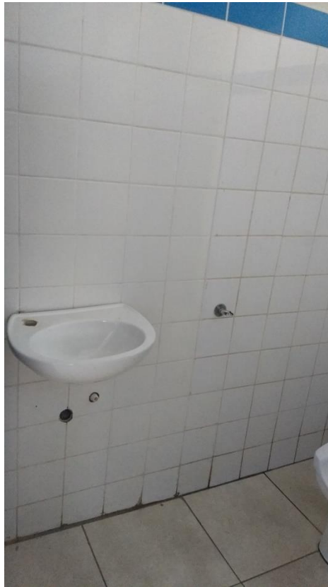
Foto 24– Escola Municipal Jalile Barbosa– Lavatório
