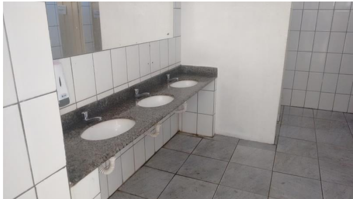
Foto 22 – Lavatório– Escola Estadual São José
