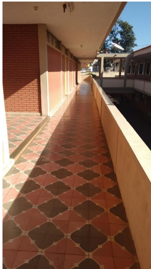
Corredor – 2º pavimento
