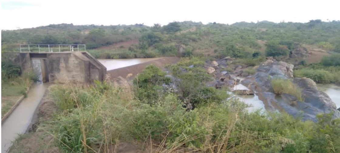
Foto 1- Barragem de captação de água na Vila Ulónguè. Fonte: Autor, Dezembro de 2015.
