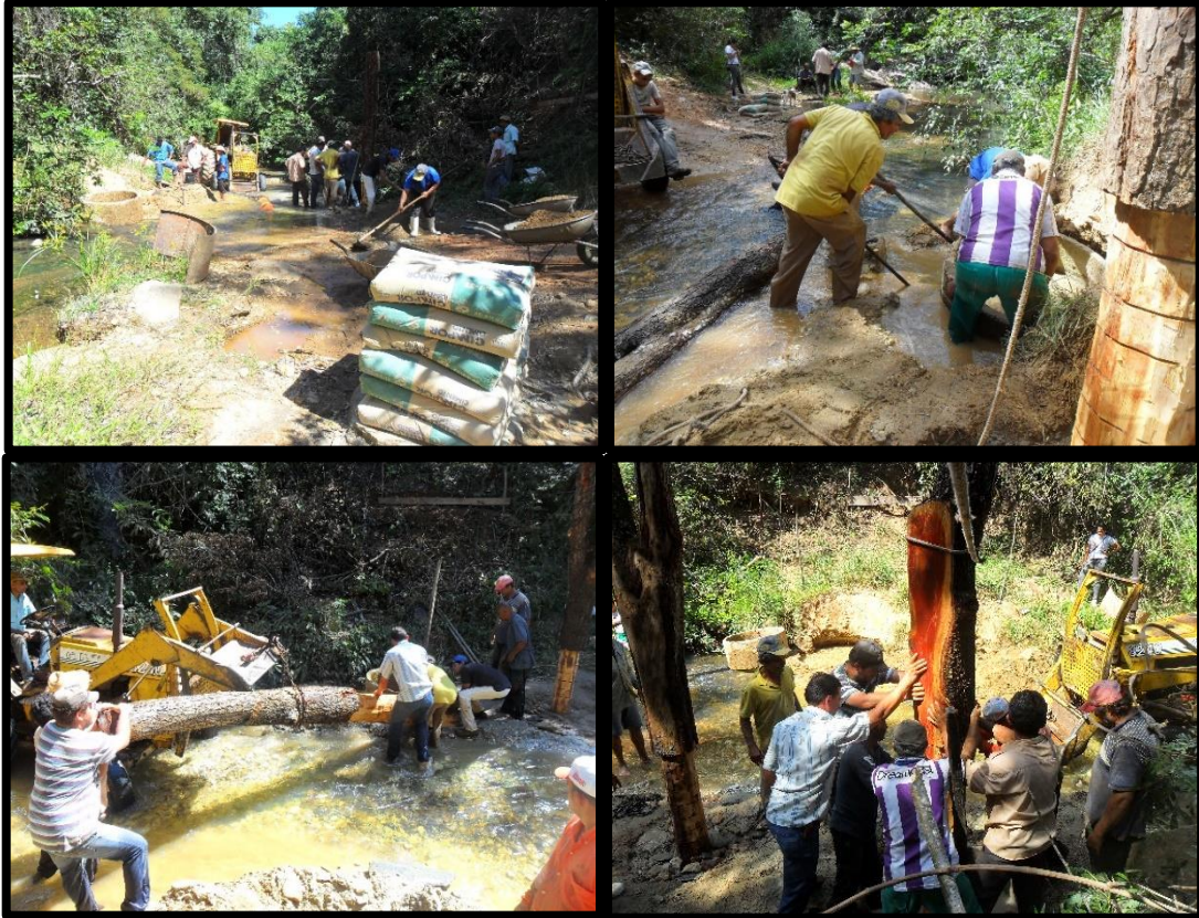
Fotografia 7 – Assentamento Olga Benário/Ipameri/GO: mutirão para construir ponte
