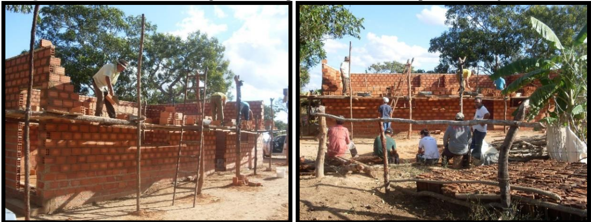
Fotografia 6 – Assentamento Olga Benário/Ipameri/GO: mutirão para construção de moradia
