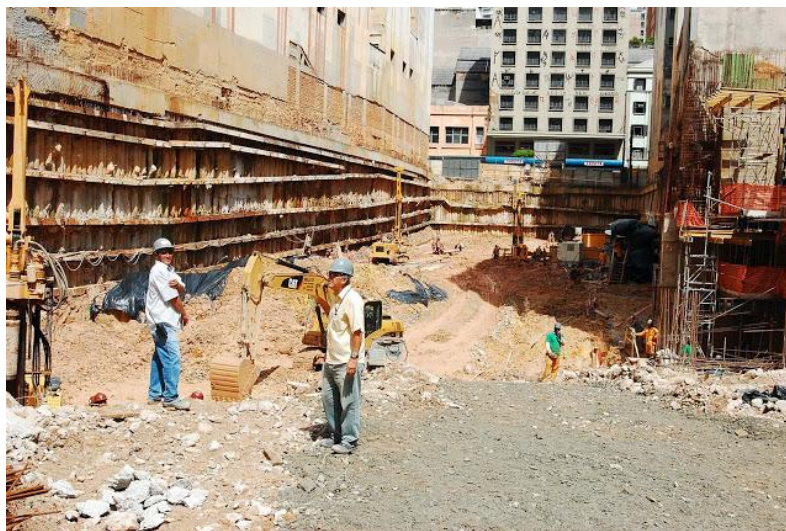
Figura 65 - Área escavada para construção do subsolo.
