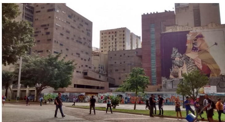
Figura 74 - Vista do Vale do Anhangabaú para o conjunto do módulo II em fase de implantação.
