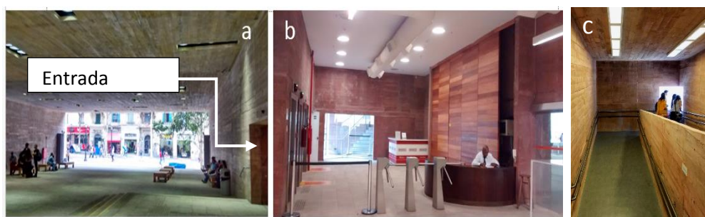
Figura 64 - Acessibilidade: Entrada principal da Praça das Artes: a) acesso coberto,; b) hall de entrada e acesso aos elevadores; c) rampas de acesso.
