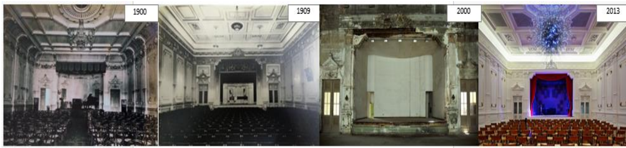
Figura 23: 1900 Salão Steinway do Hotel Panorama; 1909 Salão Carlos Gomes do Conservatório Dramático e Musical; 2000 total de degradação e 2013 Sala Mário de Andrade restaurada para fazer parte do conjunto da Praça das Artes.
