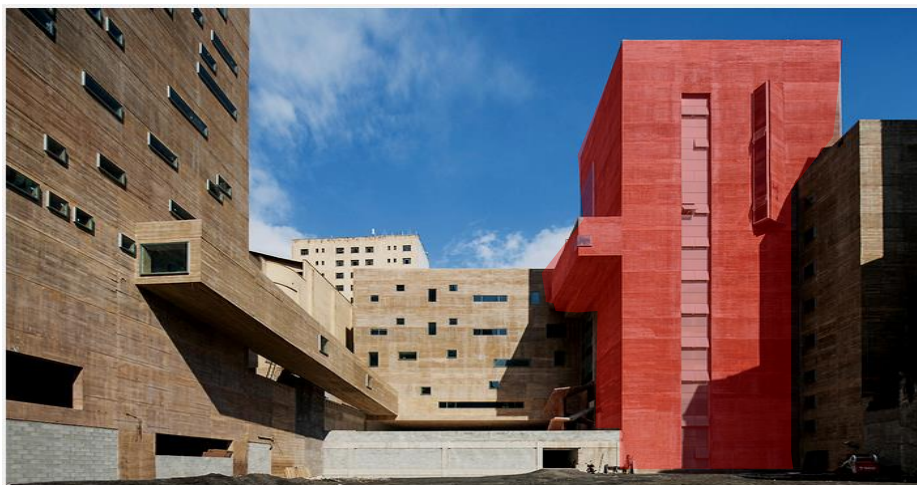
Figura 63 -Praça das Artes: pigmentos oxido de ferro e cromo para tingimento do concreto: vermelho do edifício central e ocre no restante do conjunto.
