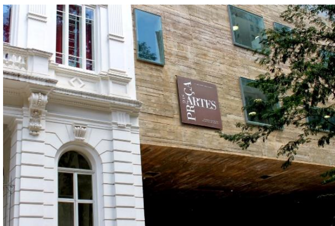
Figura 73 - Detalhe da Híbridação - Entrada pela Rua São João.
