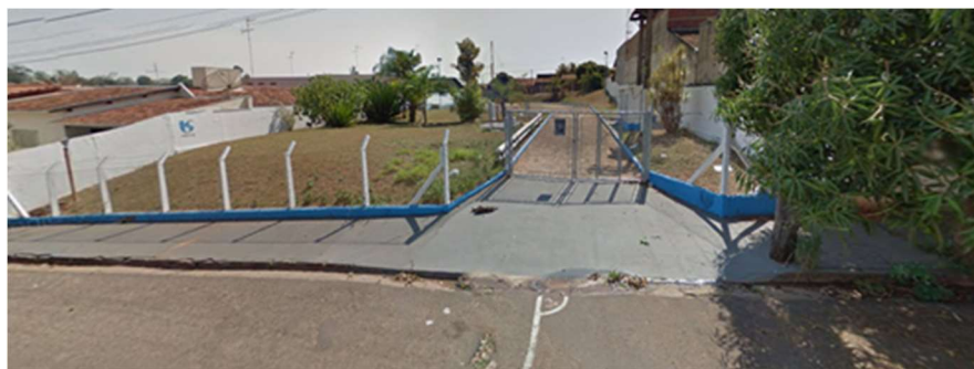
Figura 23: Fachada do PPS 10 (DAEE).
