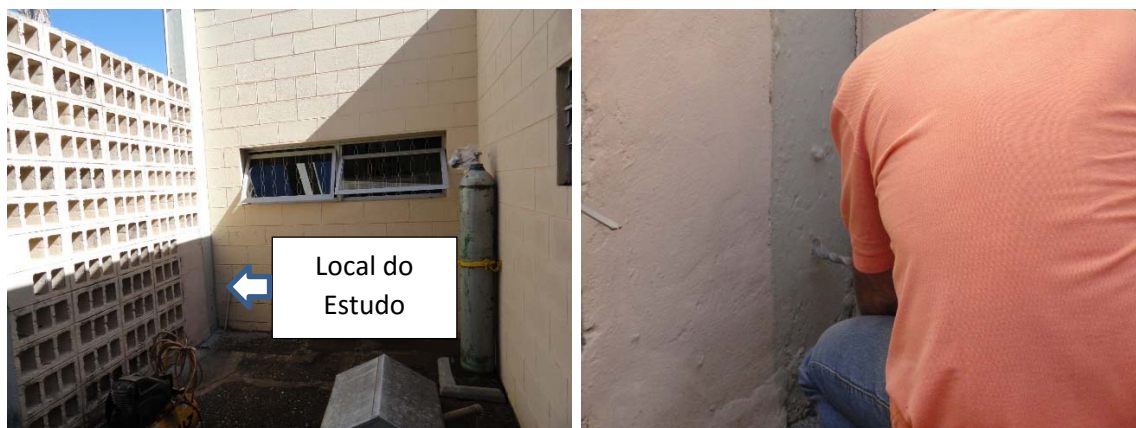
Figura 66 - Pilar do LCEC onde foi medida a umidade interna no concreto.
