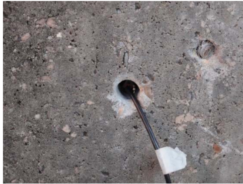
Figura 60 - Verificação da umidade interna no concreto.
