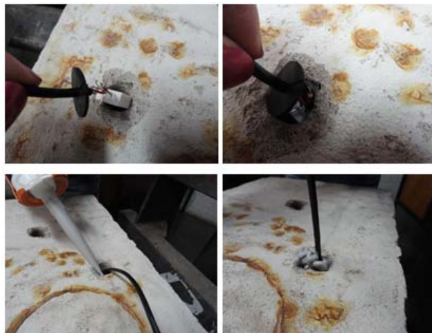
Figura 52- Inserção e selamento do sensor no furo.
