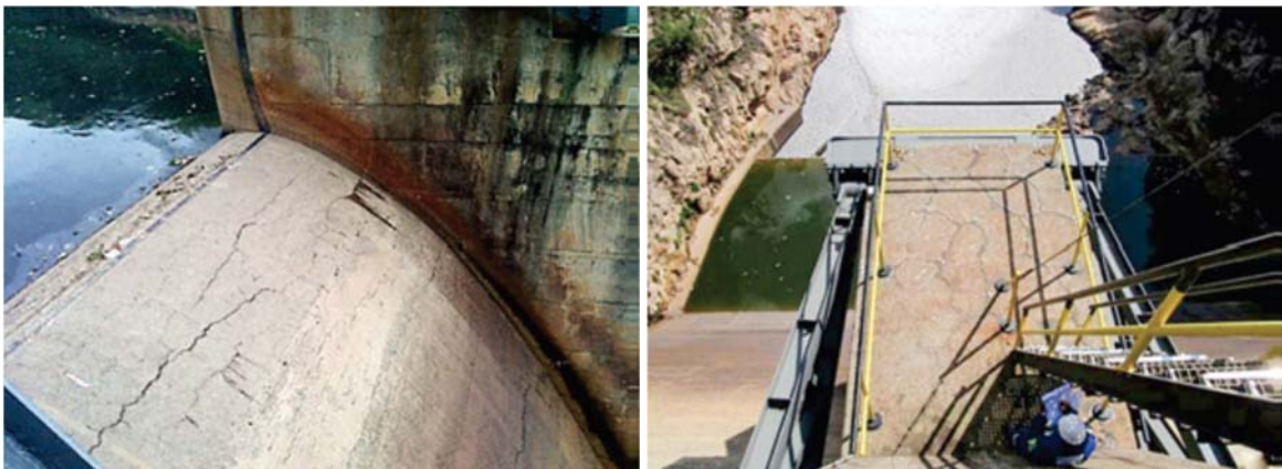
Figura 2 - Fissuras nos vertedouros da barragem e fissuras aleatórias no topo do contraforte.
