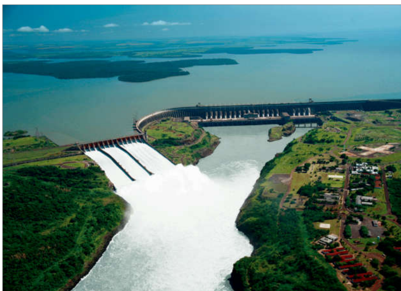
Figura 13 - Reservatório da Usina Hidroelétrica de Itaipu Binacional
