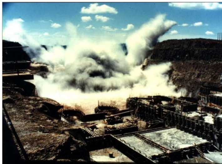
Figura 12 - Explosão do canal de desvio do Rio Paraná
