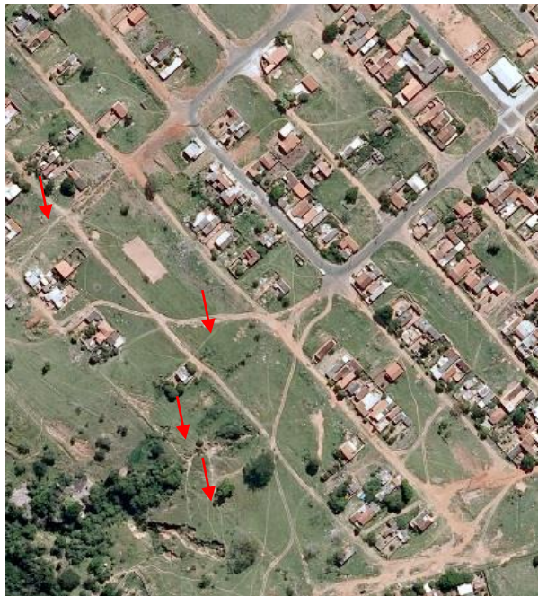
Figura 45 - Sulcos erosivos no término das ruas pavimentadas, no bairro Pousada da Esperança II.
