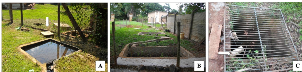
Figura 2. “Wetland” construído em 2011. A: Caixa receptora do efluente do setor de ranicultura; B: vista geral do "wetland"; C: Saída do efluente para os viveiros após passagem pelo "wetland".
