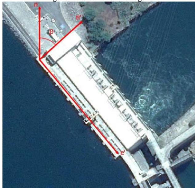
Figura 4 – Sistema da Barragem.
