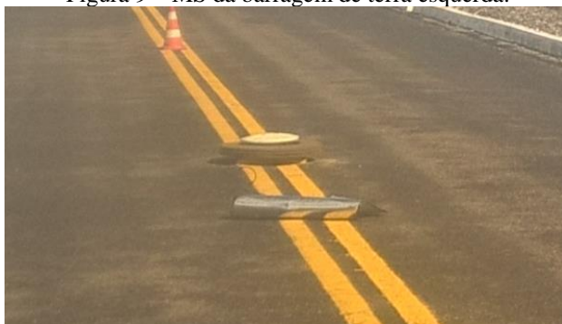
Figura 9 – MS da barragem de terra esquerda.
