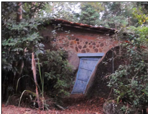
Figura 87 - Casa construída em depósito de tálus (Pnt48).
