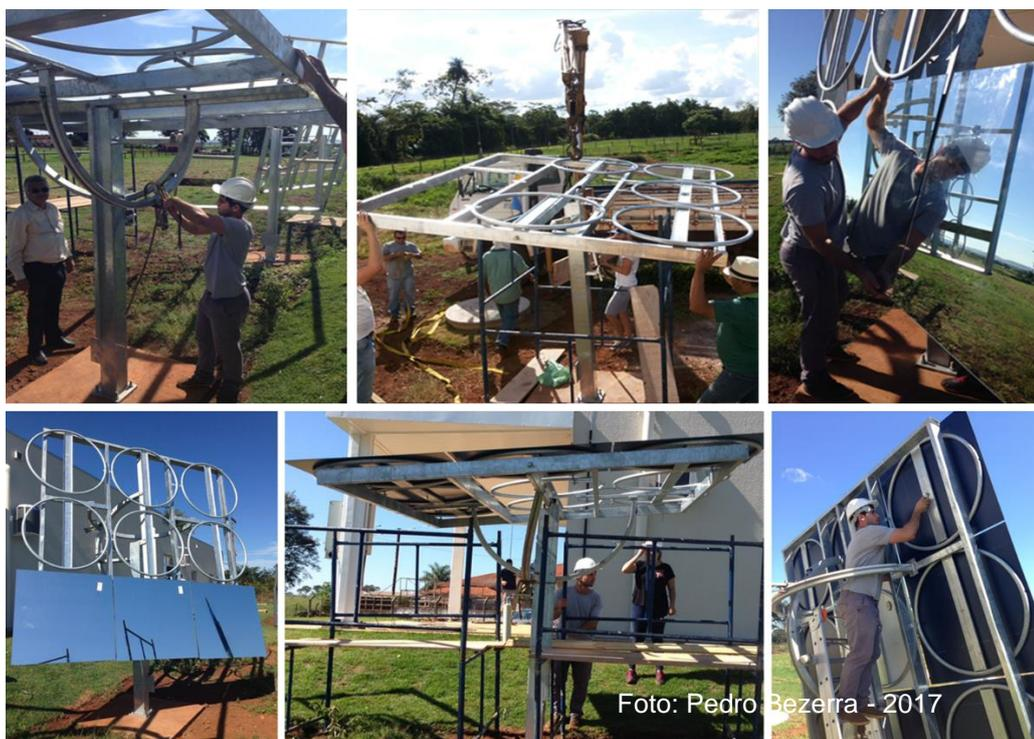
**Figura 12 - Montagem do heliostato Heliotano**
