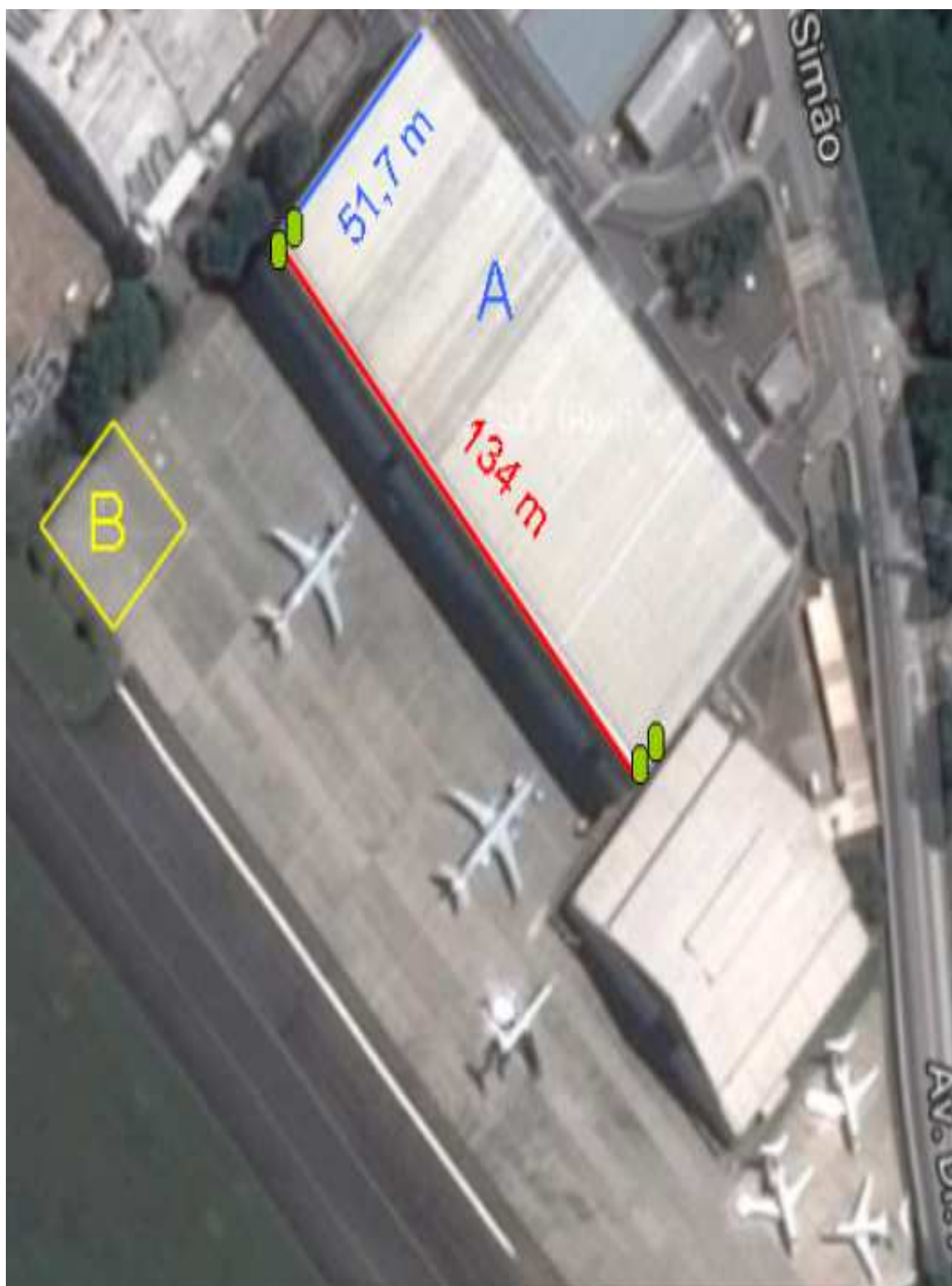
Figura 14. Prédio de Entregas de Aeronaves - foto aérea.
