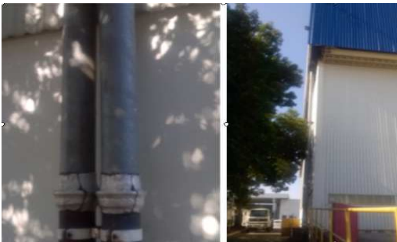
Figura 13. Tubulações de captação de água de chuva.
