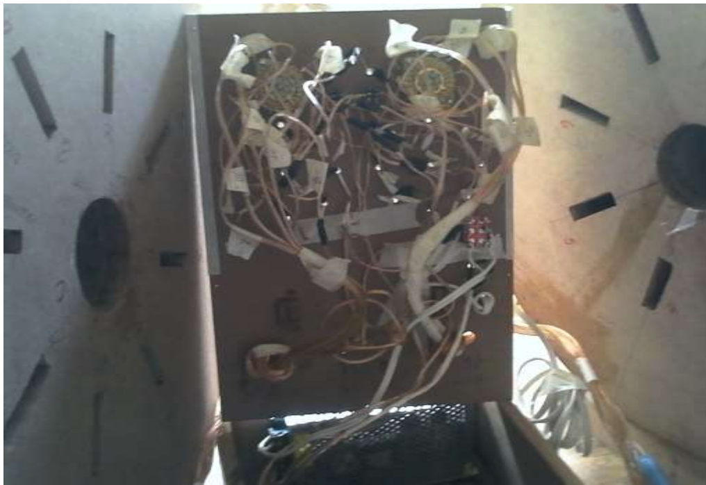
Figura 46 – Foto da vista dos circuitos internos da caixa de controle.
