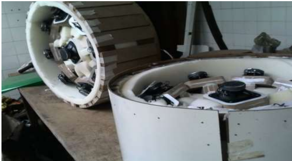
Figura 39 – Foto terminando a colocação das ripas externas e acabamento de Eucatex.
