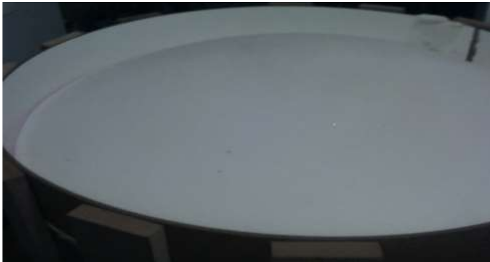
Figura 37 – Foto detalhe da colocação da isolamento acústica interna.
