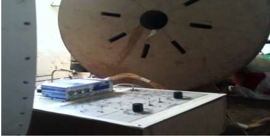
Figura 47 – Foto caixa de controle terminada e desligada.
