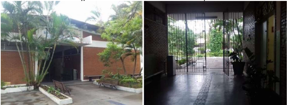
Figura 14 – Portão de acesso à administração
