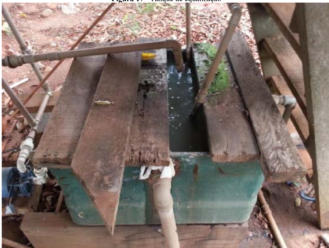
Figura 17 - Tanque de equalização
