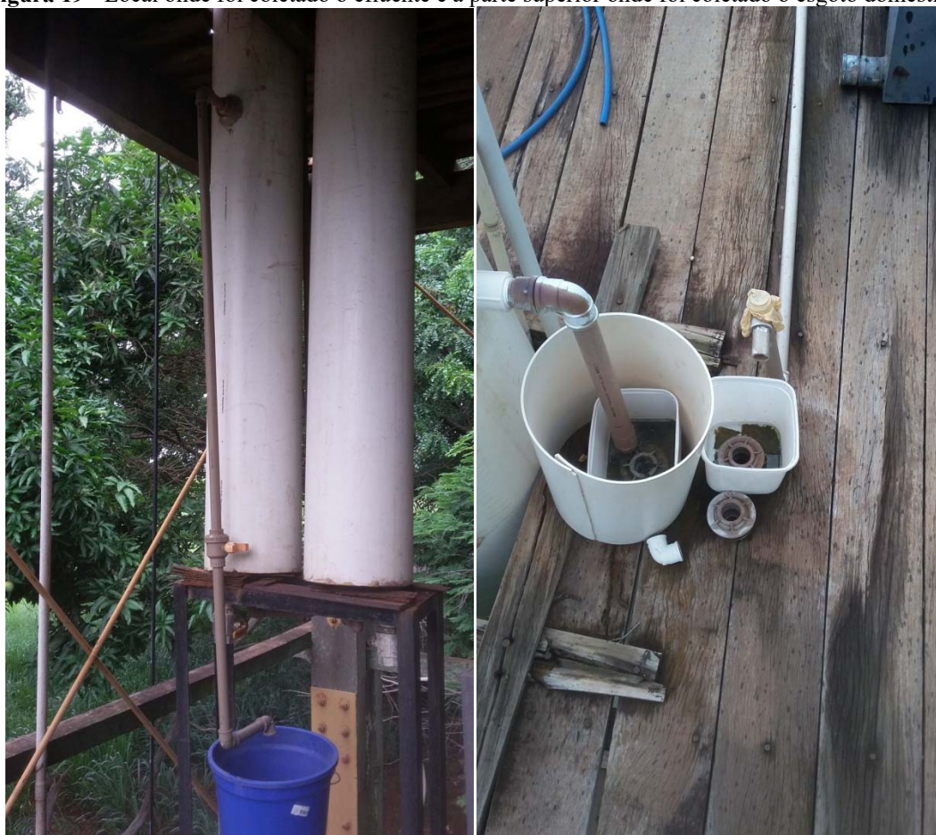
Figura 19 - Local onde foi coletado o efluente e a parte superior onde foi coletado o esgoto doméstico
