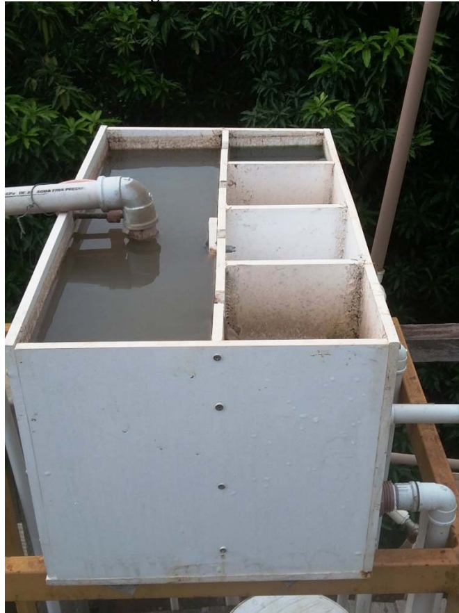
Figura 18 - Caixa de nível
