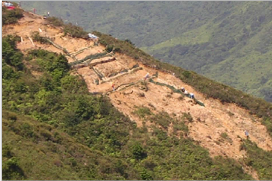
Figura 8 – Combinação de técnicas para reparar cicatrizes de deslizamento de terra.
