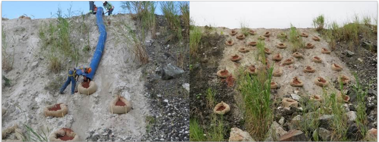
Figura 42 – Preenchimento do modelo estrutural guirlanda com solo-substrato/sementes.
