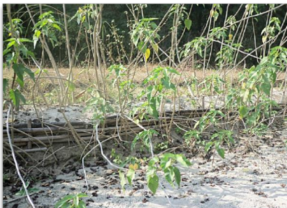
Figura 6 – Margem de rio estabilizada com barragens vegetativas.
