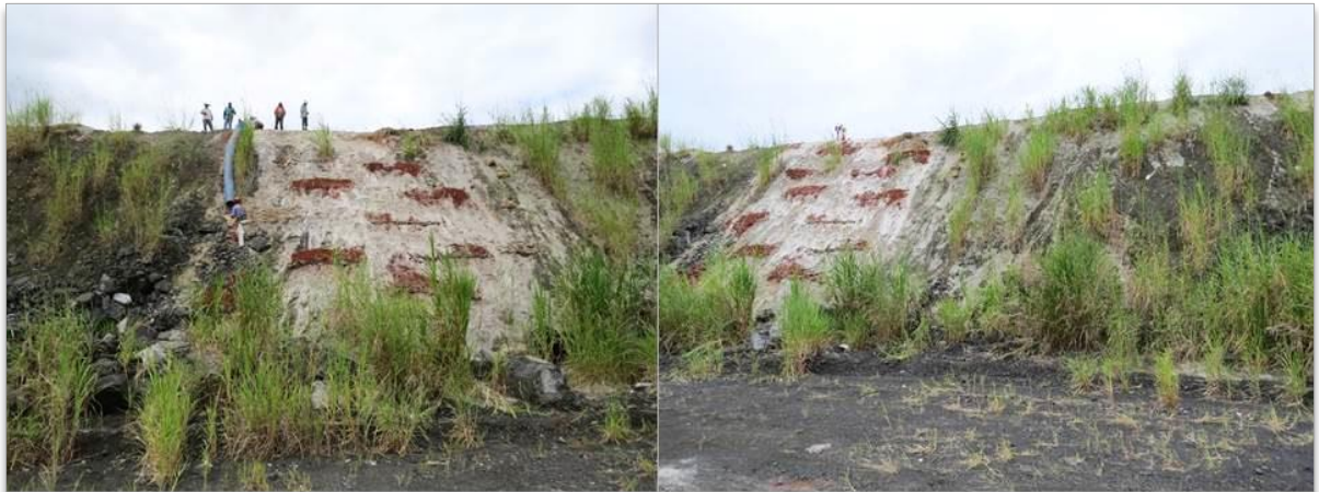
Figura 37 – Modelo estrutural colmeia instalado e preenchido com solo-substrato
