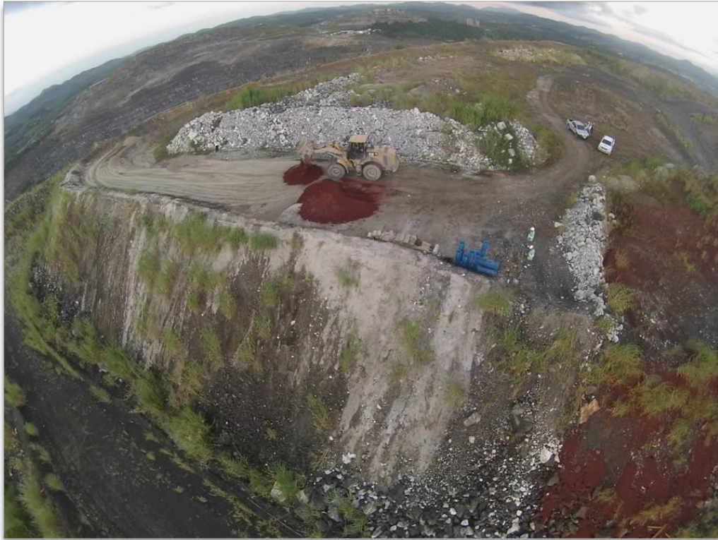
Figura 34 – Homogeneização do material de preenchimento dos modelos estruturais.
