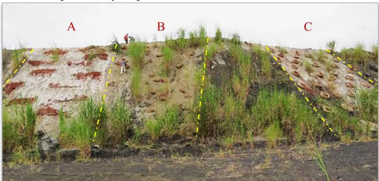
Figura 43 – Aspecto geral do talude com os modelos estruturais instalados.
