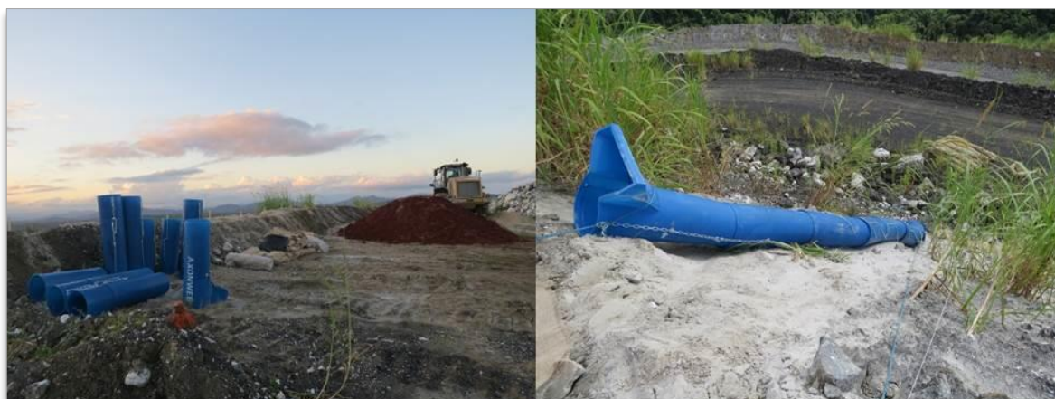
Figura 35 – Duto condutor de solo.
