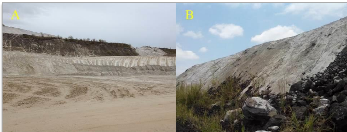
Figura 32 – Regularização da superfície do talude com areia calcária.
