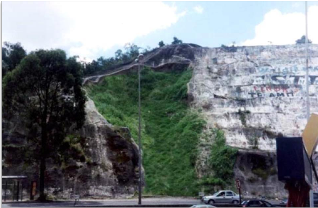
Figura 12 – Vista geral do talude Ponteio após intervenções.
