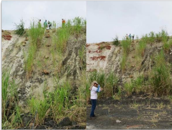
Figura 38 – Processo de instalação do modelo estrutural retentor.
