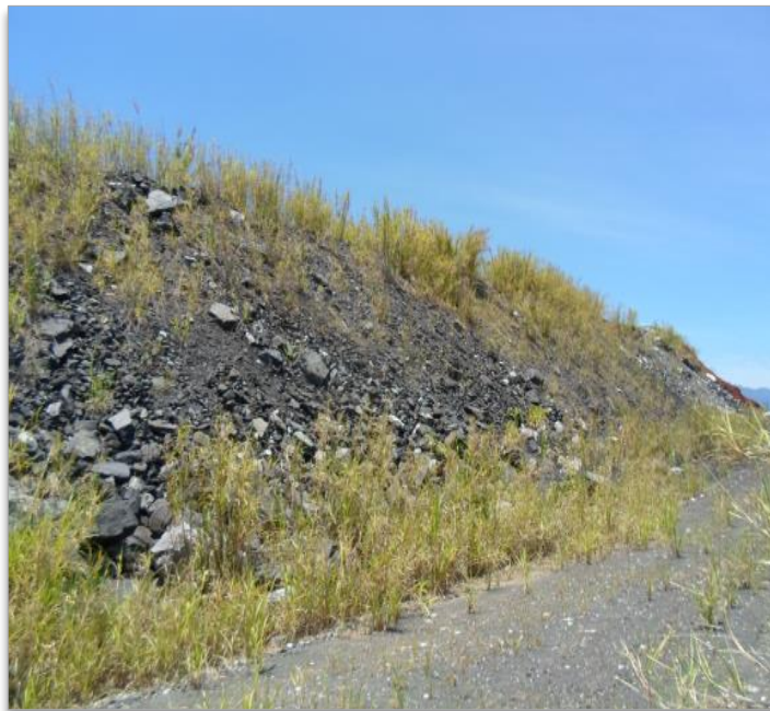
Figura 19 – Aspecto geral do talude da pilha de estéril antes da intervenção.
