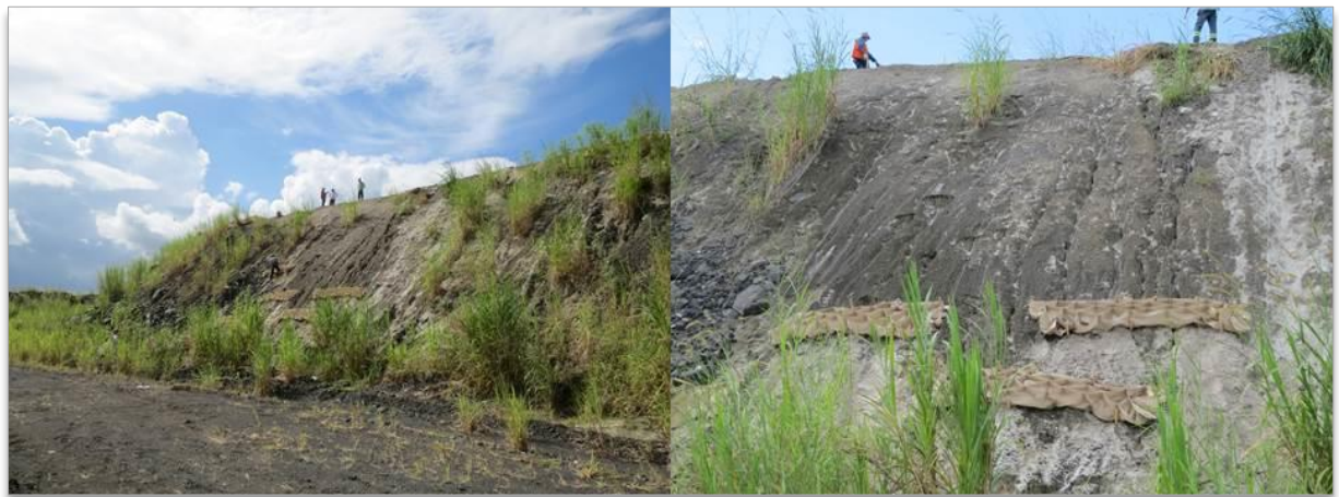
Figura 36 – Processo de instalação do modelo estrutural colmeia.
