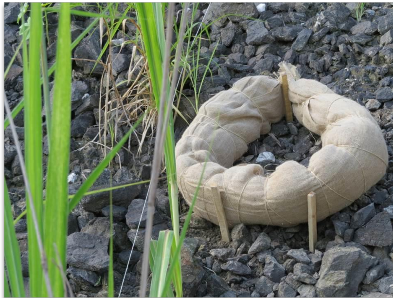
Figura 41 – Detalhe do modelo guirlanda instalado no talude.
