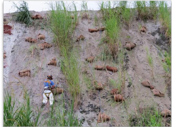
Figura 39 – Aspecto geral do talude após instalação do modelo estrutural retentor.
