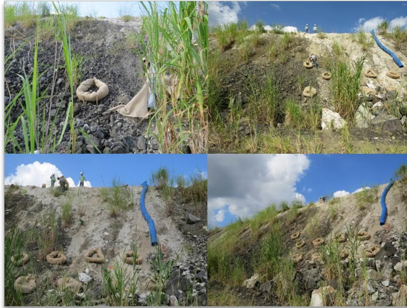
Figura 40 – Processo de instalação do modelo estrutural guirlanda.
