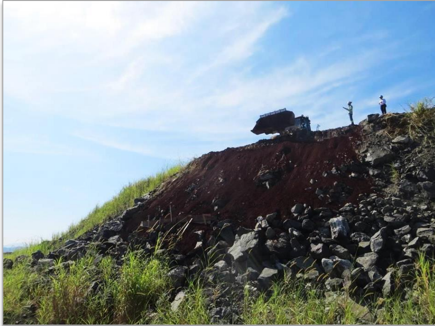
Figura 23 – Colocação de solo-substrato no talude experimental.
