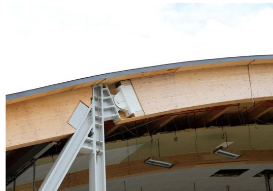
b) União das vigas com conexão em aço.
