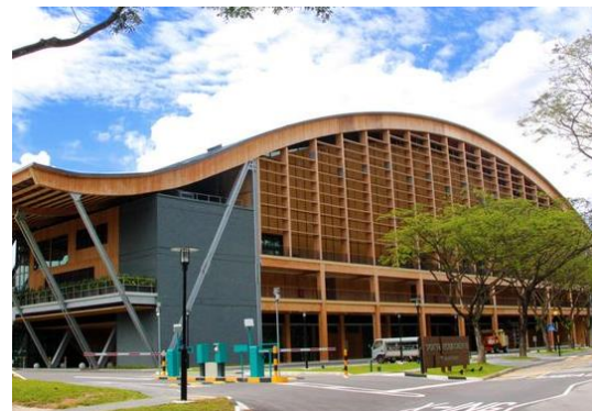
d) Visão geral do pavilhão esportivo.
