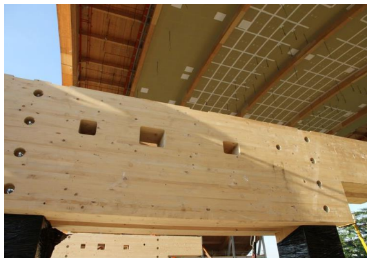
c) Viga de MLC com usinagem em CNC.
