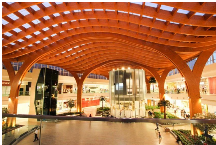
Figura 1 – Estrutura em MLC – Shopping Iguatemi Fortaleza.
