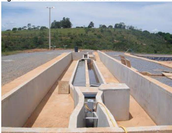
Figura 5 - Desarenador ou caixa de areia
