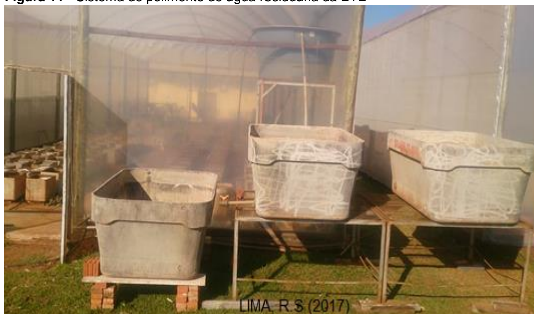
Figura 11 - Sistema de polimento de água residuária da ETE
