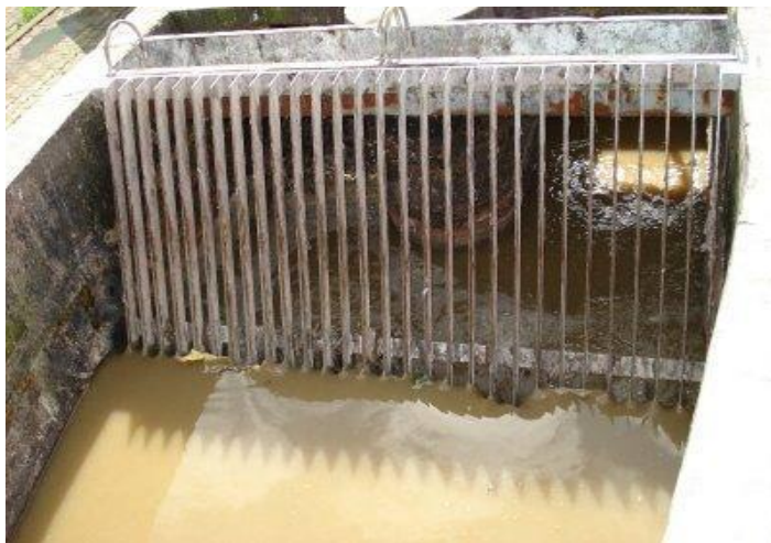
Figura 4 – Gradeamento do esgoto
