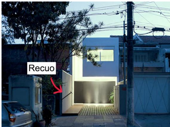
c. Edificação sem muro, recuada do início do lote.
