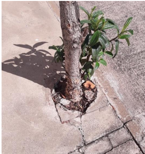
Figura 17. Calçada PARCIALMENTE ADEQUADAS Rachaduras leves e pouca raiz exposta. Fonte: a autora
