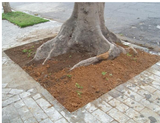
Figura 23. Raiz superficial, porém sem danos ao piso
