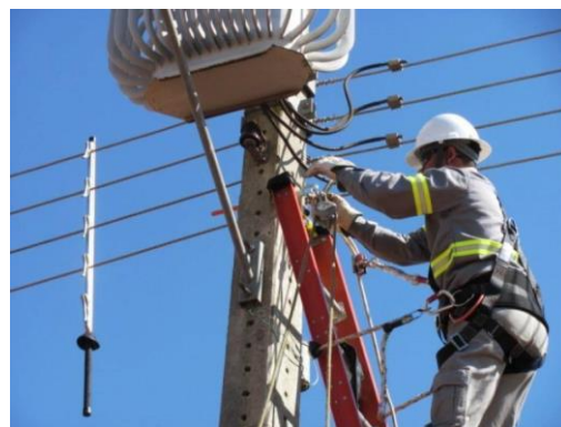
Figura 8. Rede elétrica Isolada (DBS ENGENHARIA E CONSULTORIA)
