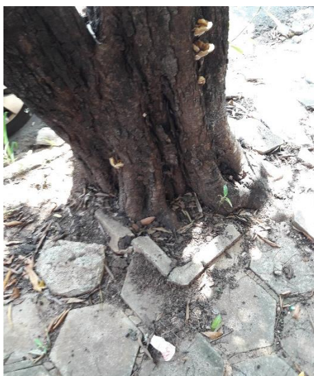
Figura 24. Raiz superficial com danos ao piso e arredores Fonte: a autora
