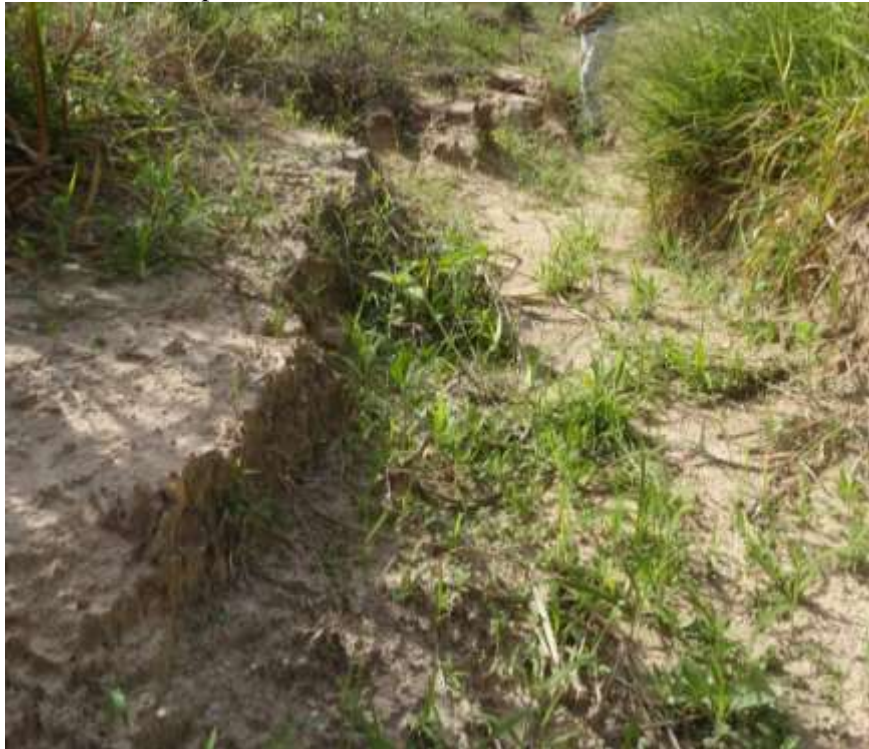
Figura 14: Área de aplicação da técnica de barramentos de bambu para contenção da erosão e da parcela de monitoramento em Vera Cruz
