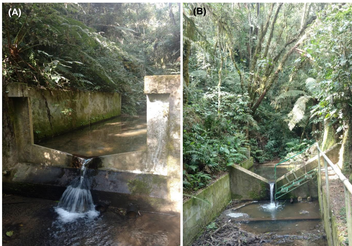
Figura 1.3 – Vertedores e locais de coleta das amostras de água nas microbacias com vegetação nativa (A) e florestas plantadas de Pinus (B)
