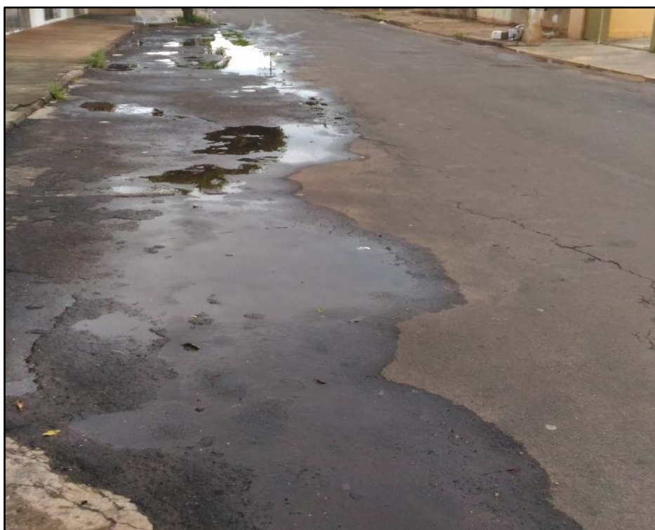
Figura 6 - Armazenamento de água de chuva no Asfalto, Ilha Solteira-SP
