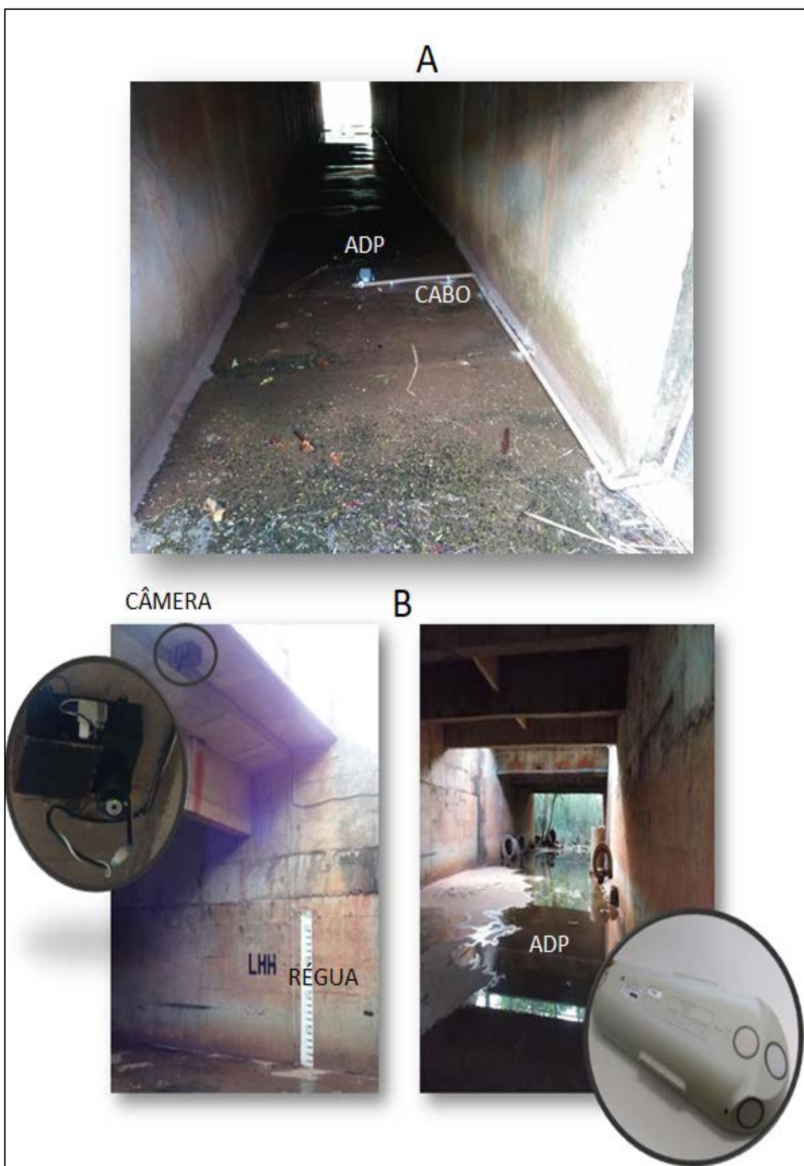
Figura 31 - Equipamentos Instalados em Campo A - Ponto 1 B- Ponto 2
