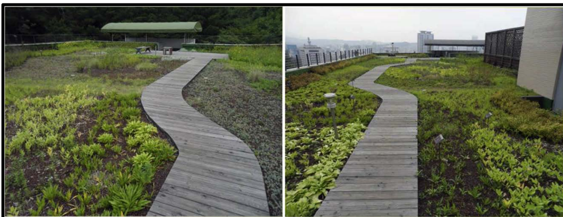
Figura 5 - Exemplo de Telhado Verde em Seoul, Coreia do Sul
