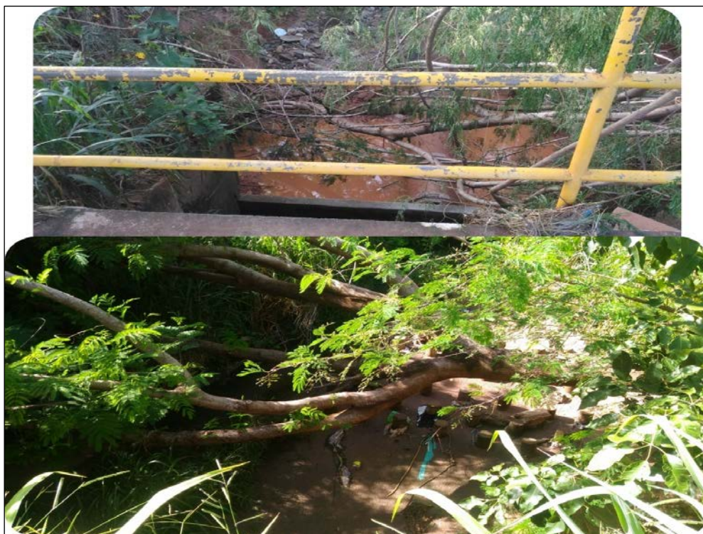
Figura 53 - Árvores tombadas no canal de macrodrenagem.
