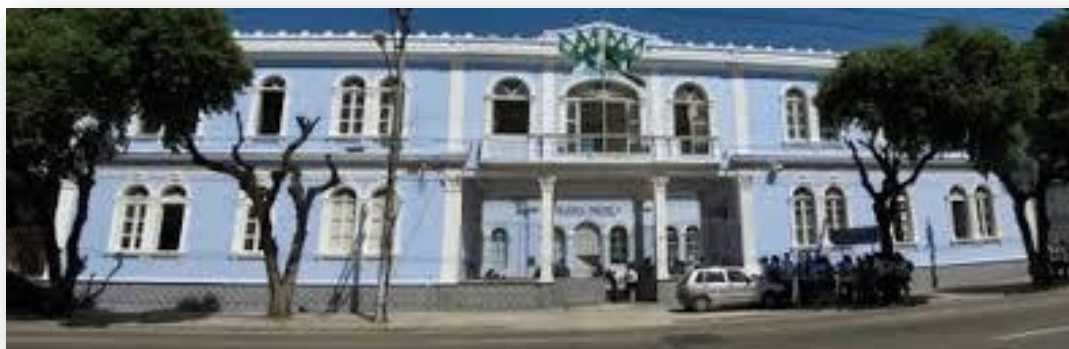
Figura 4.1: Fachada do Colégio Pedro II – Realengo
