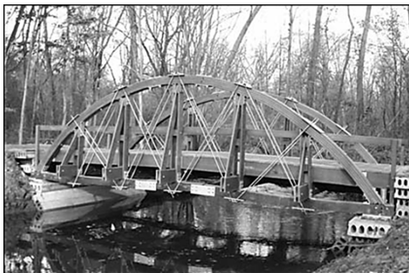
Figura 2.12 - Ponte o construída com compósito de plástico reciclado e madeira, sobre rio Hudson (Fonte: McLaren et al., 2002)
