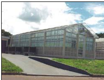
Figura 2.1. Casa de vegetação localizada na FCAV-UNESP, campus de Jaboticabal. Fonte: internet.
