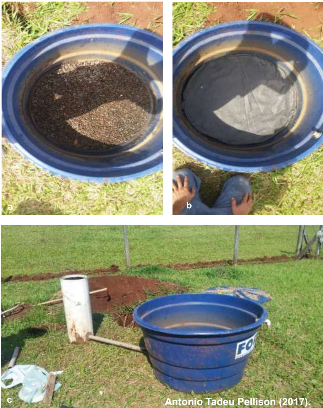
Figura 27 - a) Preenchimento da caixa d'água com brita nº 1; b) manta bidim cobrindo a brita; c) ligação do tanque intermediário com a caixa d'água.
