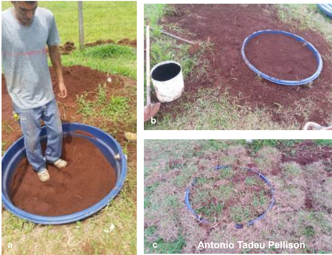
Figura 28 - a) preenchimento da caixa d'água com a terra retirada do local; b) preenchimento total de terra; c) plantio de grama.
